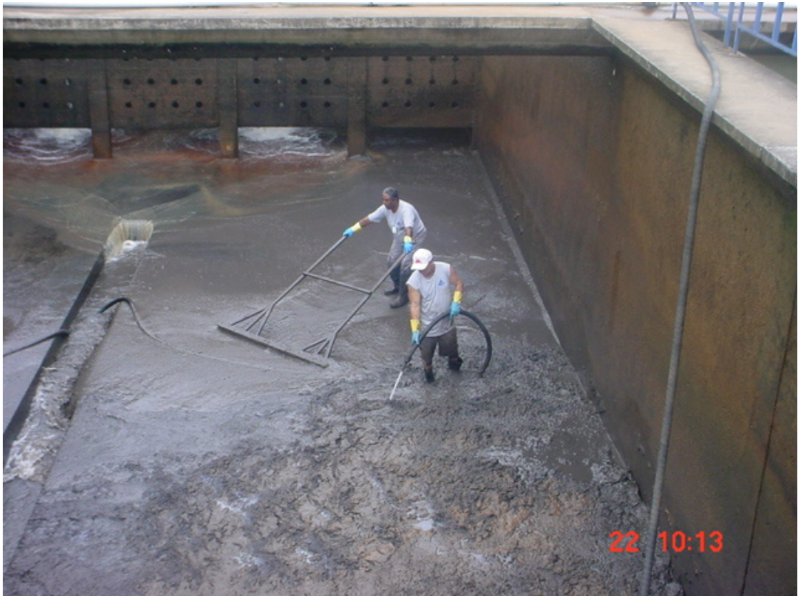
Figura 4.1. Limpeza de um decantador da ETA-NH.
