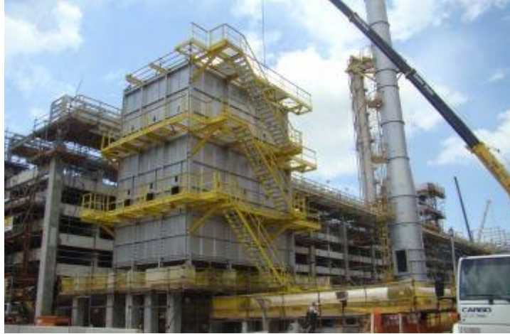
Figura 5.1- Forno reformador da refinaria Landulpho Alves localizada na Bahia sem a tubulação conectada
