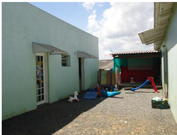
Fotografia 11. Pátio interno e entradas das salas do MI e Jardim B
