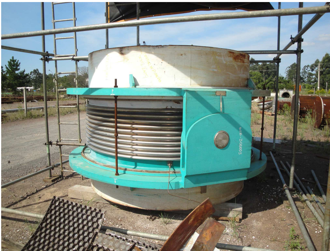
Figura 7 - Foto da junta SXB-300003 em estudo, removida do duto na parada de manutenção de 2010.
