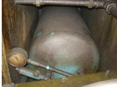
Fig. 13 – Manômetros e válvulas de segurança. (Fonte empresa “X”)
