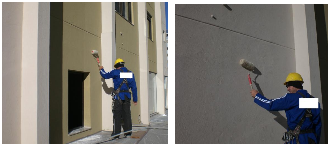
Figura 16 – Aplicação da tinta de acabamento hidrorrepelente e elastomérica
