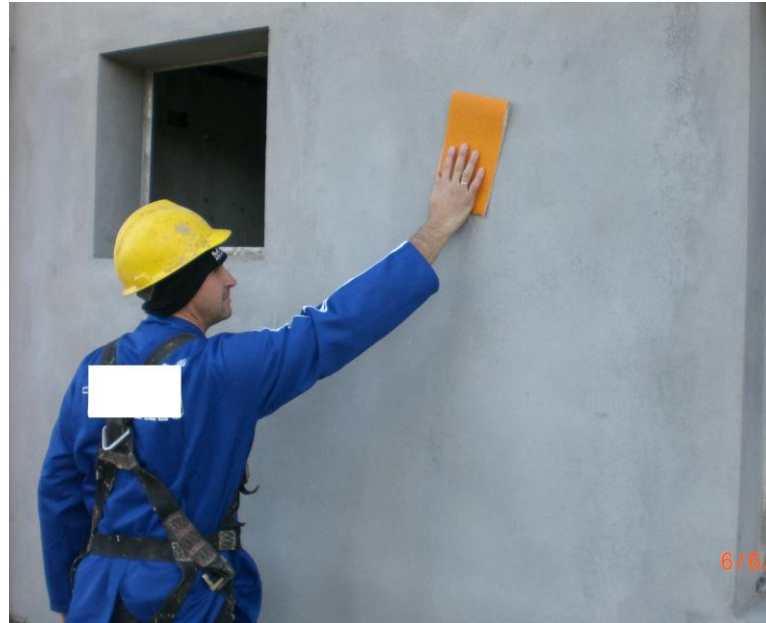
Figura 12 – Lixamento da superfície
