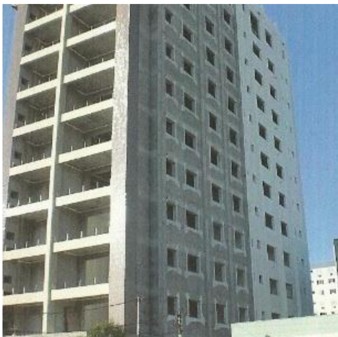
Figura 9 – Vista da fachada lateral da edificação
