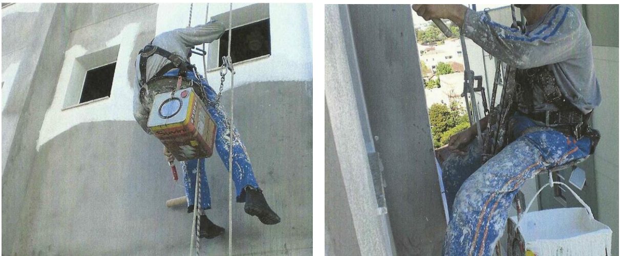
Figura 13 – Aplicação de fundo preparador
