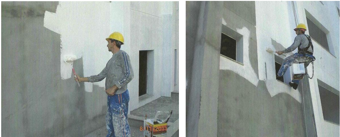
Figura 15 – Aplicação tinta externa contra microfissuras
