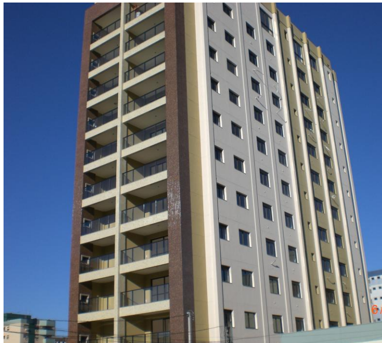
Figura 17 – Pintura recém executada
