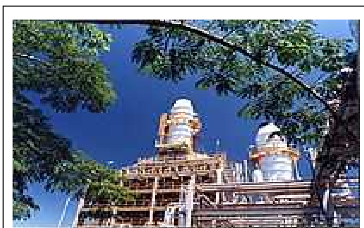
Figura 2.6 - Turbina a gás. Fonte: COPESUL,2001.
