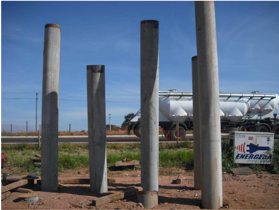
Figura 25 – Detalhe do comprimento não cravado das estacas na obra
