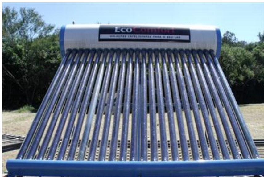
Figura 3.5 - Coletor de tubos.
