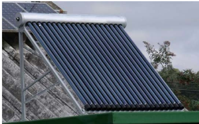
Figura 1.2 - Coletor de tubo evacuado.
