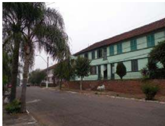
Figura 04: Foto da Vila IAPI Fonte: LATUS, 2010
