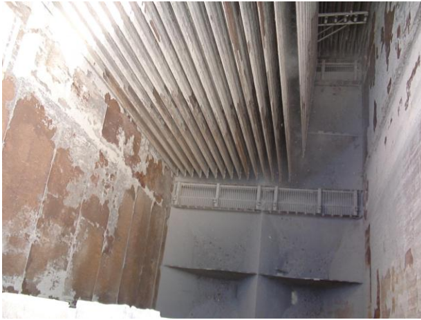
Figura 6 – Desmontagem do PE – 04
