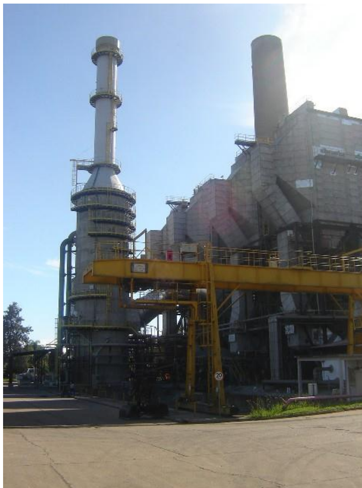
Figura 4 – Vista da Usina Termelétrica
