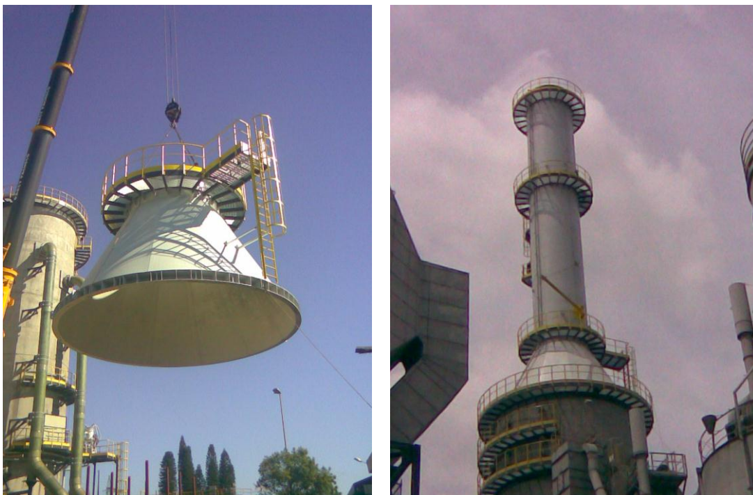
Figura 10 – a. e b. Montagem da chaminé metálica FGD
