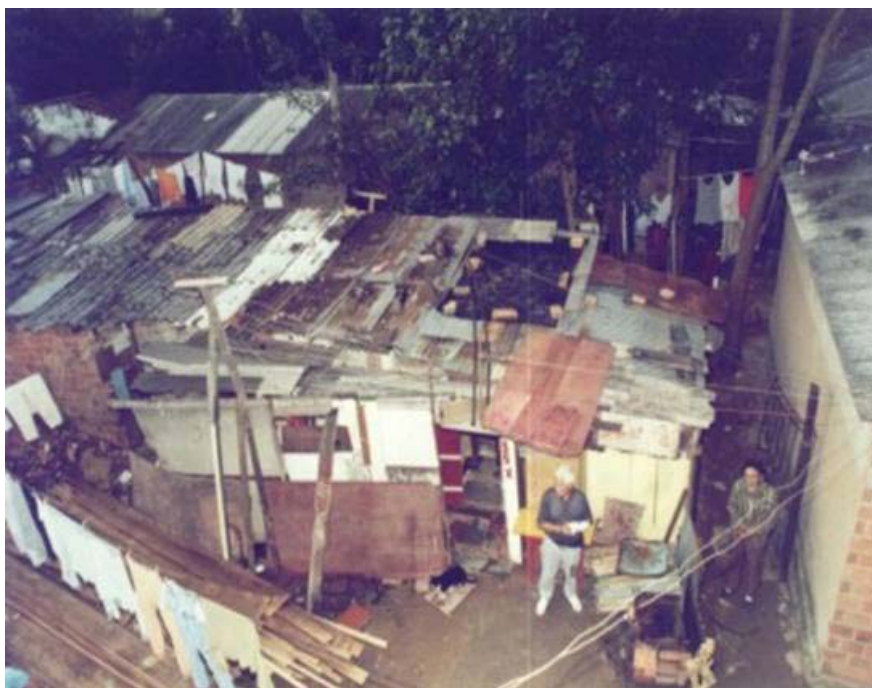
FIGURA 4: vista aérea da área de ocupação irregular que deu origem ao Condomínio dos Anjos.
