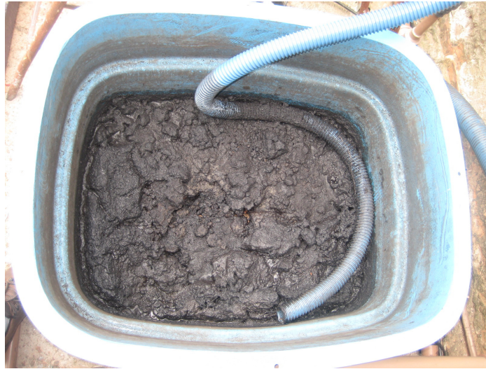
Figura 16. Processo FFC-A. Vista superior do leito de secagem de lodo.
