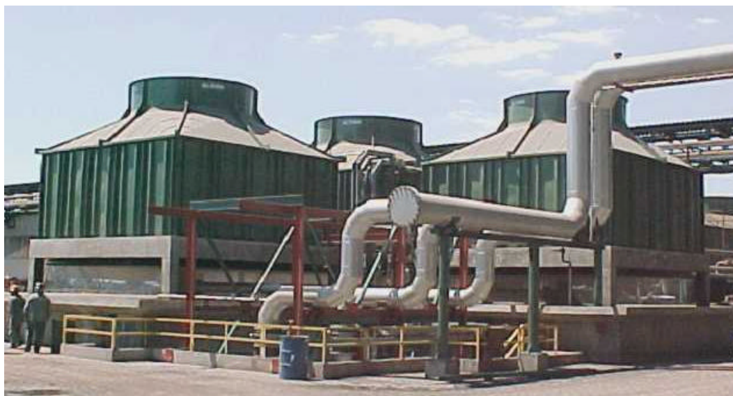
Figura 40 - Sistema de recirculação de água industrial utilizada no resfriamento dos dutos do sistema de despoejamento. Vista das torres de resfriamento.
