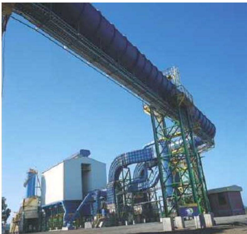
Figura 32 - Vista do duto secundário (diâmetro 3 metros), casa de filtros, silo de pó e prédio do comando elétrico.
