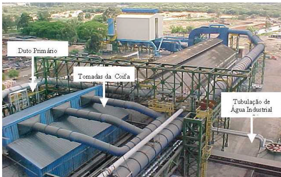
Figura 31 - Vista superior do sistema de despoejamento, mostrando a coifa sobre o forno elétrico, os dutos secundário e primário e uma vista parcial do sistema de água industrial.
