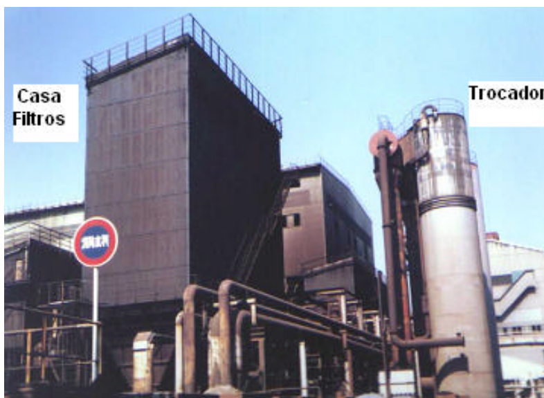
Figura 16 - Casa de filtros e câmara de resfriamento das emissões primárias
