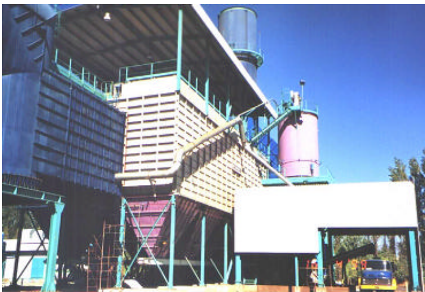
Figura 17 - Casa de filtros e sistema de pelletização de pó.
