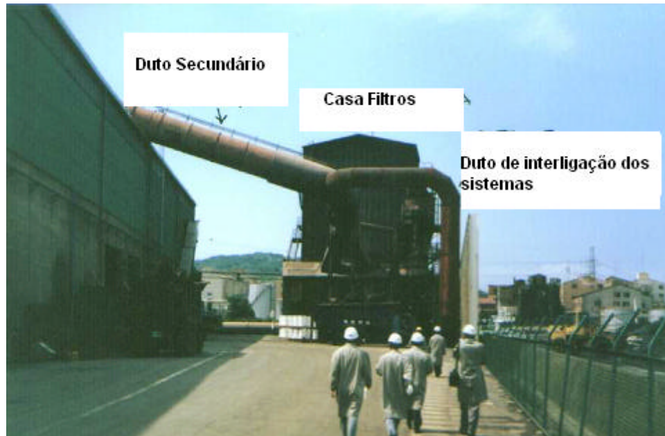
Figura 15 - Filtros cilíndricos para as emissões primárias do quarto-furo.
