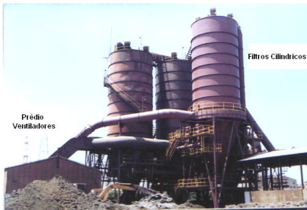
Figura 14 - Filtro com pressão positiva para os sistemas primário e secundário.
