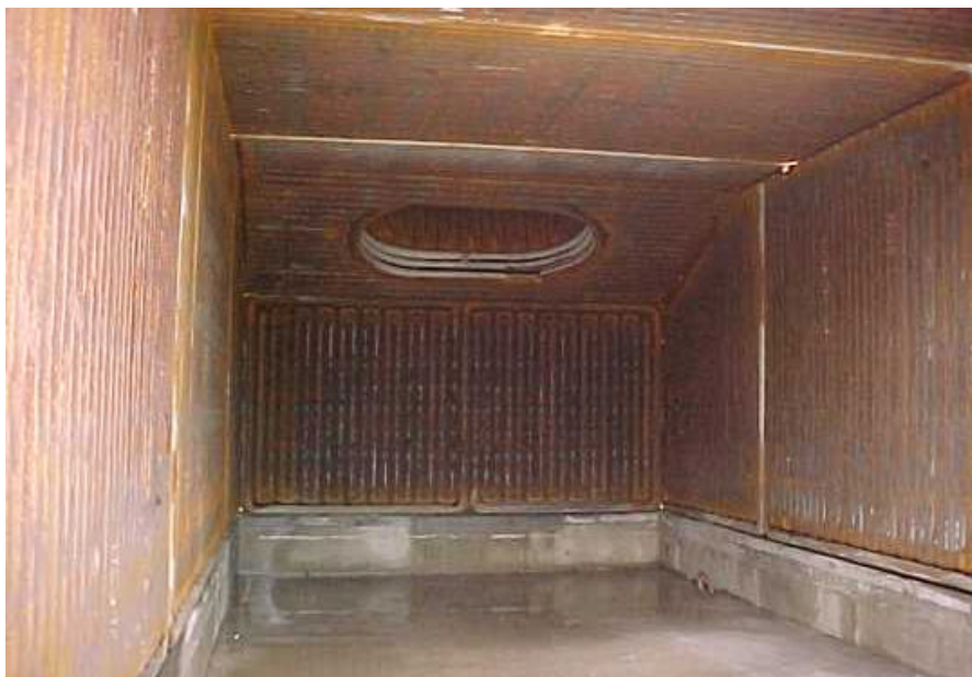
Figura 37 - Interior da câmara de combustão, mostrando a soleira de concreto, as laterais e a abóboda com os tubos resfriados à água.
