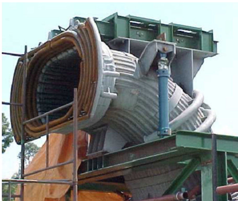
Figura 38 - Curva fixa refrigerada, montada na entrada da câmara de combustão do sistema primário.
