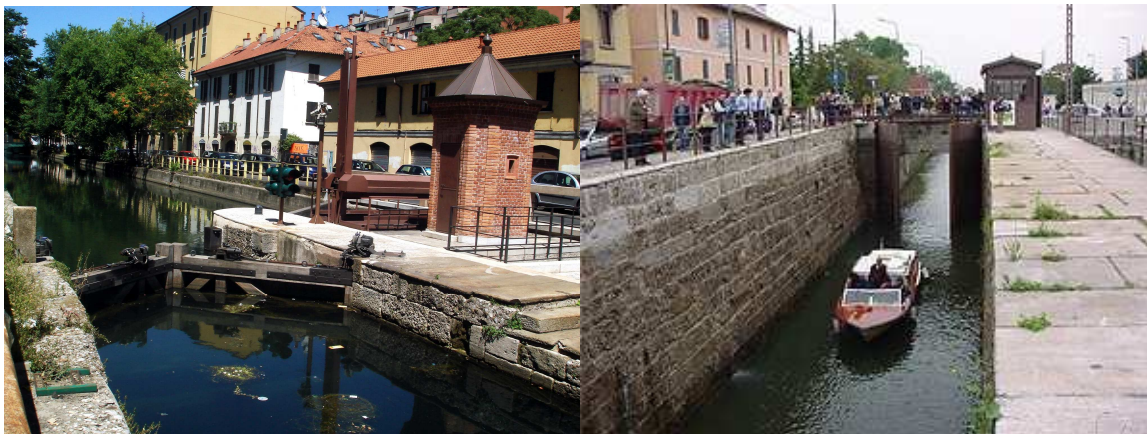
Figuras 59 e 60. A Conchetta e a Conca Fallata depois da reestruturação
