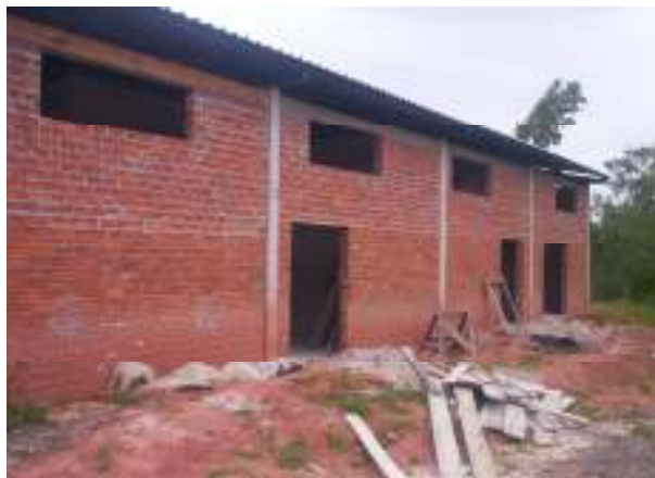
Figura 7. Novas instalações em construção, no Centro São Francisco de Assis
