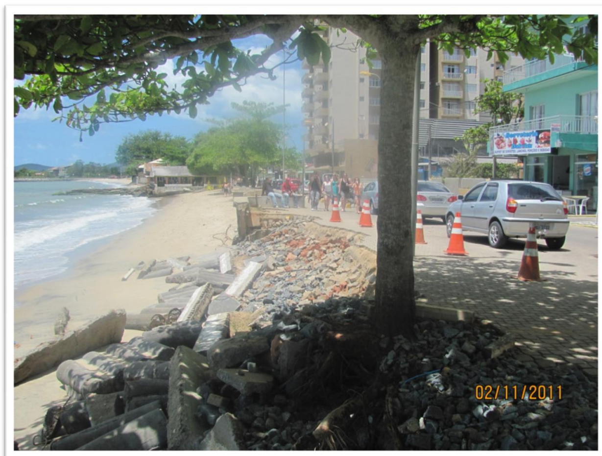
Figura 3 Situação da praia de Piçarras em novembro de 2011. Parte do calçadão destruído pela força das ondas. Foto: Diego Bitencourt.
