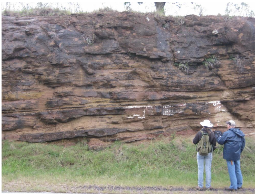
Figura 8. Visão Geral do afloramento 001 onde é possível observar a inclinação das camadas.
