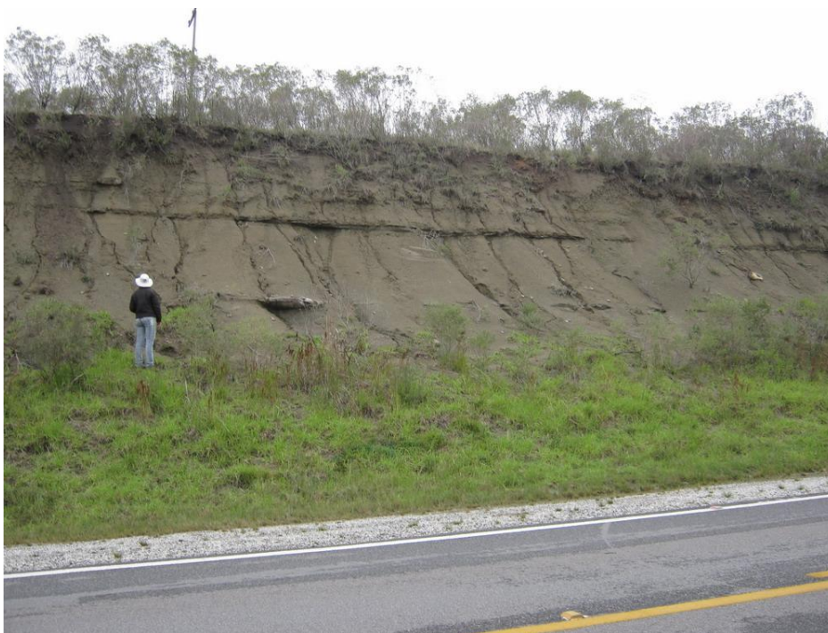
Figura 18. Visão geral do afloramento 007.
