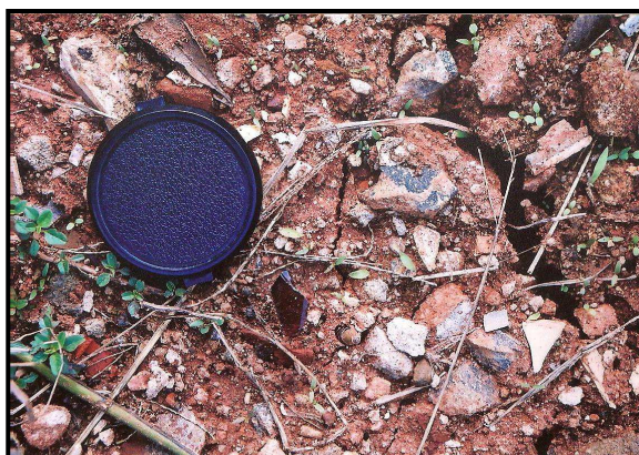
Figura 51 – Fissura no terreno evidenciando sinais de instabilidade.
