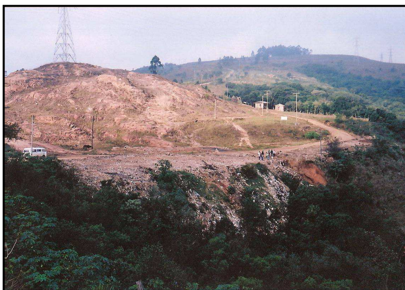
Figura 47 – Aterro de entulhos e lixo antes da ocupação na área 1, mostrando a alta declividade do talude e os fortes processos erosivos atuantes no lado direito da imagem.
