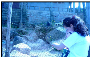
Figura 58 – Moradia 3 construída sobre matacões. Vista frontal da moradia.
