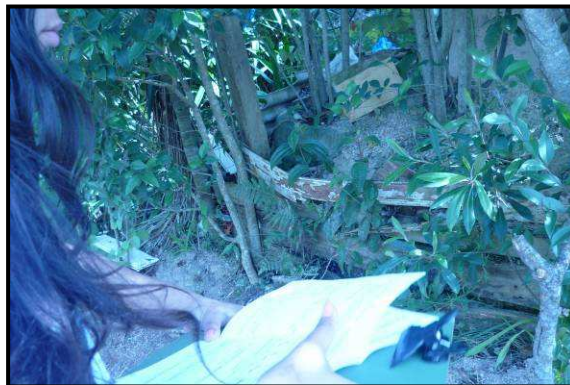
Figura 56 – Moradia 2, apresenta feições de instabilidade como o embarrigamento da cerca que detém o aterro lançado.
