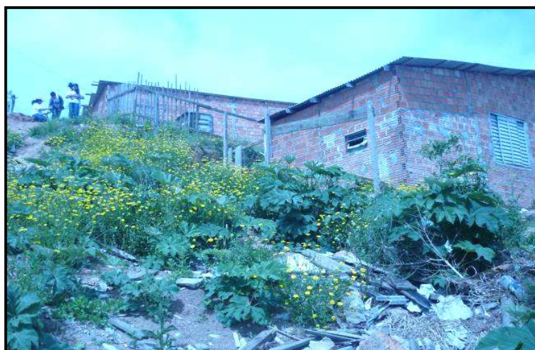
Figura 64 – Vista da encosta de alta declividade e onde há concentração de depósitos antropogênicos.
