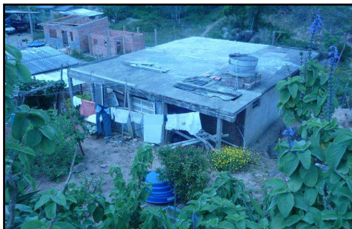
Figura 59 – Vista superior da rua Aquidaban para a moradia 3, situada próxima ao talude de corte de pedra desativada.
