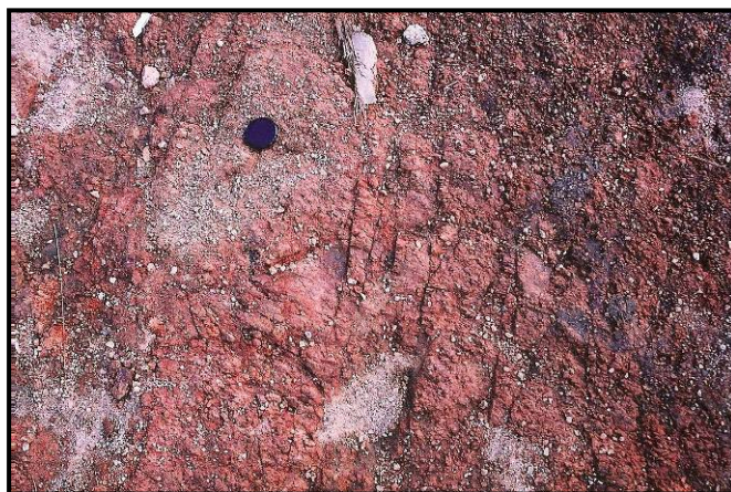
Figura 52 – Exposição do granito fraturado na borda do talude.
