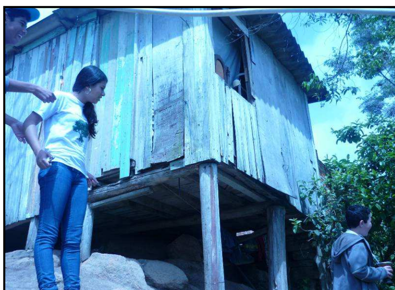
Figura 62 – Moradia 6 em condições precárias, com pilares de sustentação apoiados diretamente no solo exposto.
