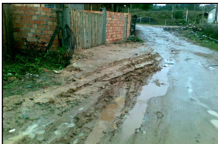
Figura 50 – Acúmulo de água na estrada aumenta a probabilidade de escorregamento na área 1.
