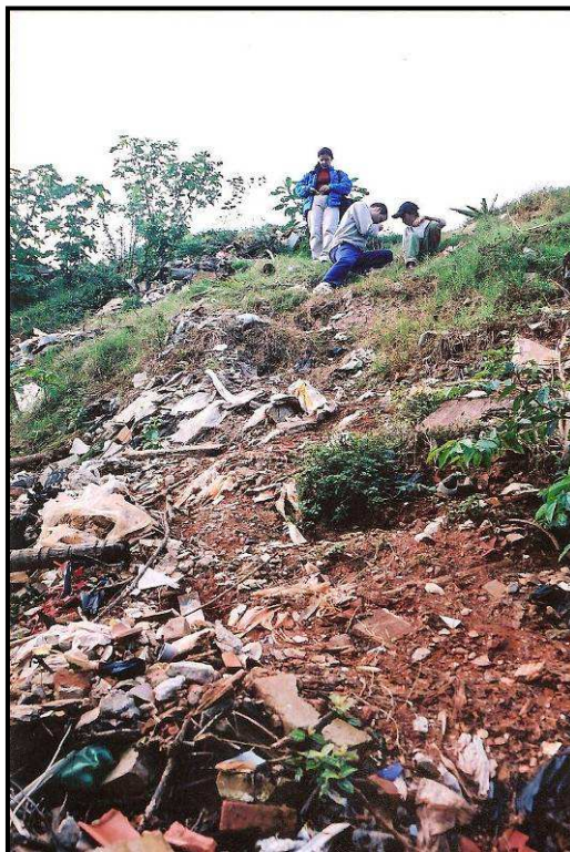
Figura 46 – Talude de alta inclinação, resultante de aterro lançado encosta abaixo.
