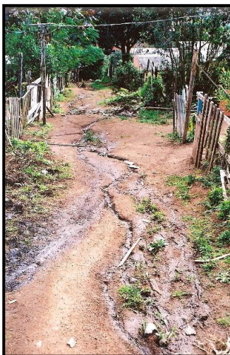
Figura 54 – Vias de acesso na área 2, com sulcos causados pelo escoamento da água e esgoto.
