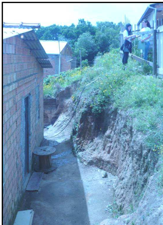
Figura 63 – Moradia próxima ao talude de corte com inclinação de 90^\circ , onde percolam água e esgoto sem canalização.
