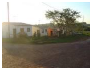
(b) Frente dos lotes para a Rua Ariano Aquino Pinto
