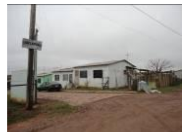
(c) Construção de abrigo para carro na lateral da moradia
