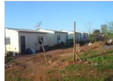
(c) fundos das casas do Conjunto Dom Moura em estado de manutenção ruim
