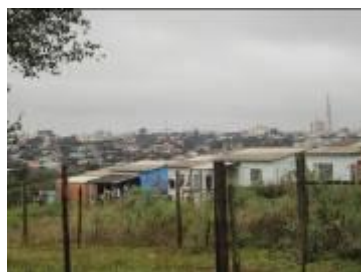
(a) Vista dos acréscimos nas casas do conjunto
