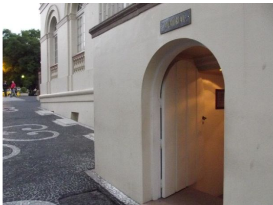
Imagem 11: Fachada lateral do Theatro São Pedro: entrada principal para o Memorial Theatro São Pedro.
