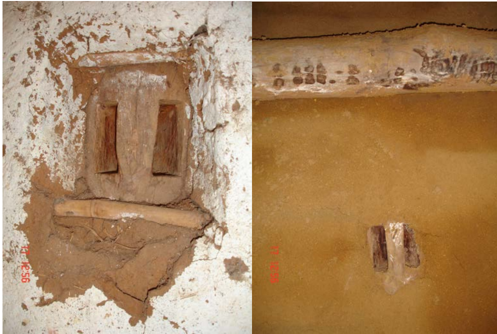
Fotos de locais de armador de rede numa casa de taipa que foi reformada com barro retirada de um poço que estavam fazendo em Espírito (17/05/2010).
