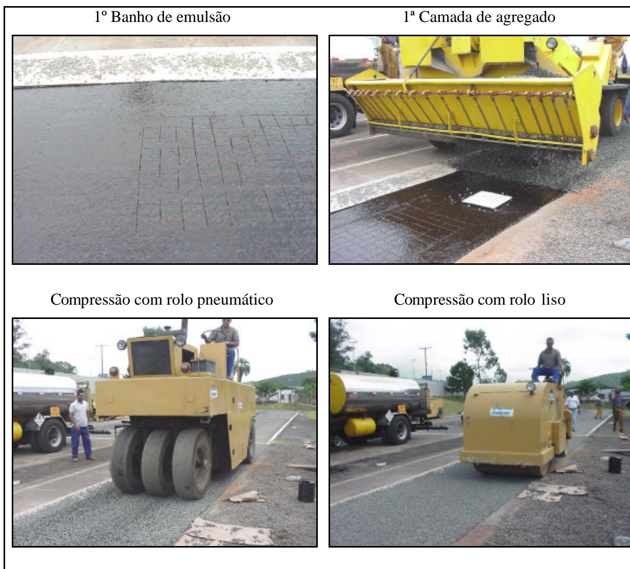
Figura 21: Etapas de execução do recapeamento em tratamento superficial
