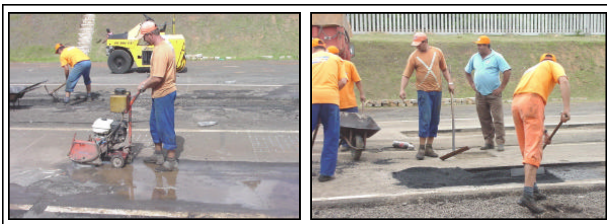
Figura 18: Execução do remendo em concreto asfáltico
