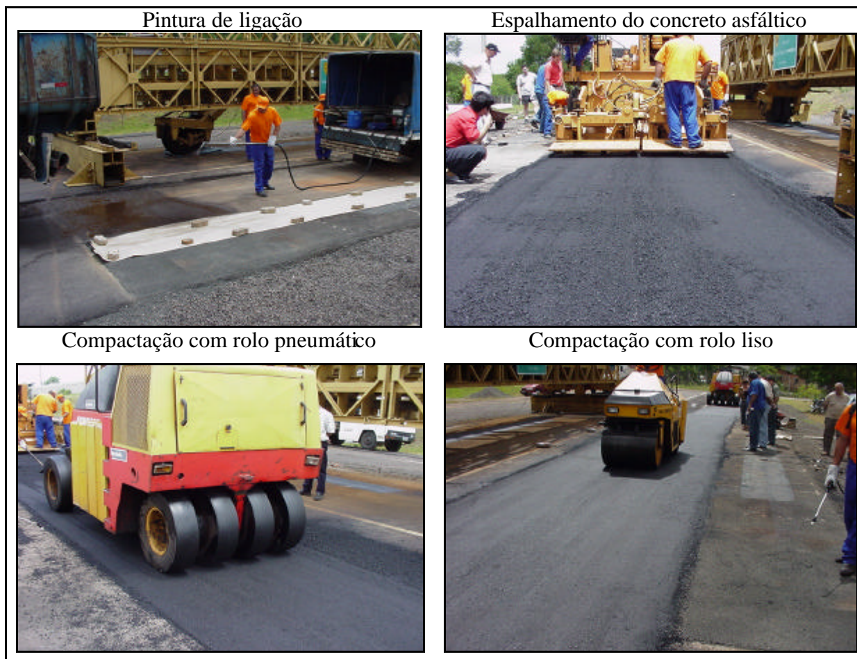
Figura 24: Execução do recapeamento em concreto asfáltico
