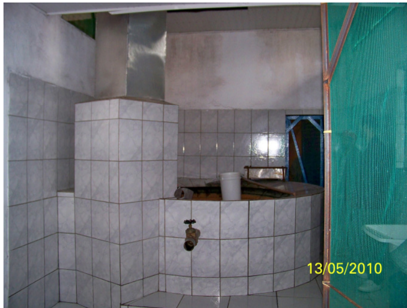
Figura 5: foto de engenho para produção de melado dentro das normas sanitárias instalado no município de Santo Antônio da Patrulha, RS. Fonte: Lindomar Arceno Cardoso, 2010.
