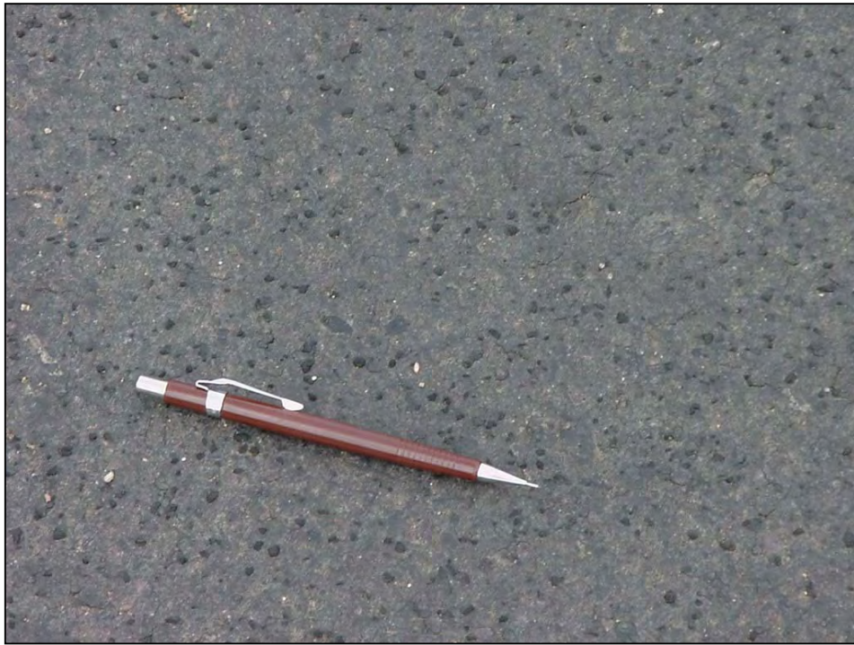
Figura 7.16 – Textura superficial imediatamente após a construção (outubro/2002)
