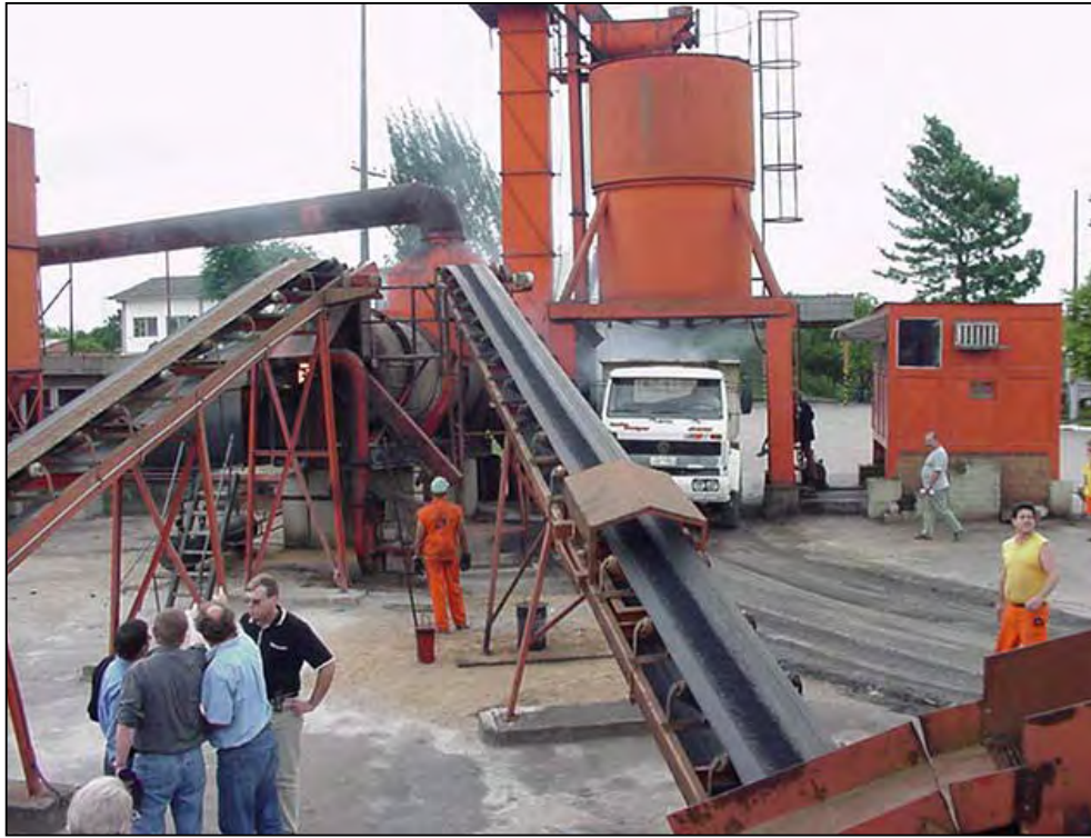
Figura 7.9 – Vista panorâmica da usina
