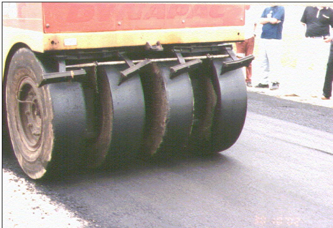
Figura 7.14 – Compactação da massa em pista com rolo pneumático
