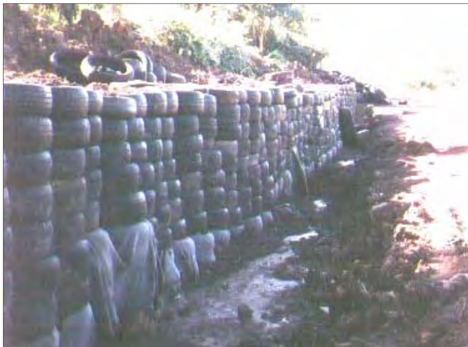
Figura 2.2 – Foto do muro de pneus executado na rodovia RS 30
