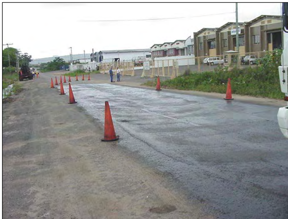
Figura 7.11 – Vista da área pintada pronta para receber novo revestimento
