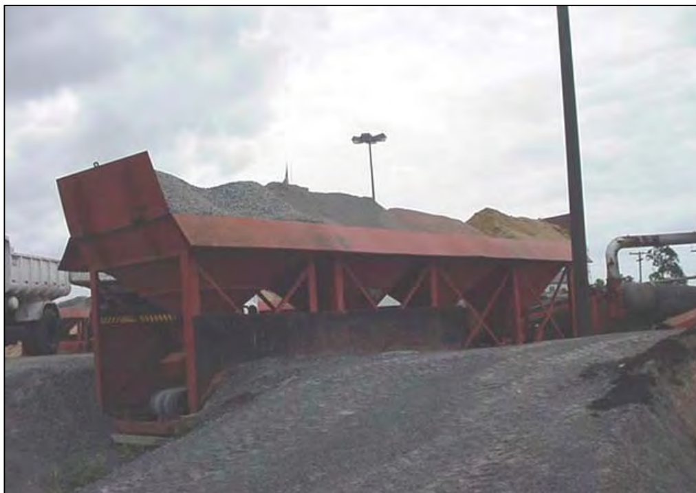
Figura 7.7 – Vista panorâmica dos silos carregados com agregados
