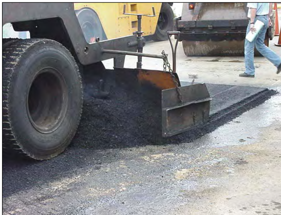
Figura 7.12 – Aplicação da massa em pista
