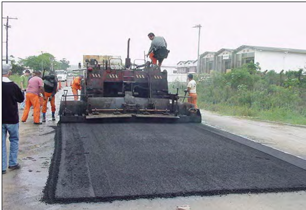
Figura 7.13 – Aplicação da massa em pista
