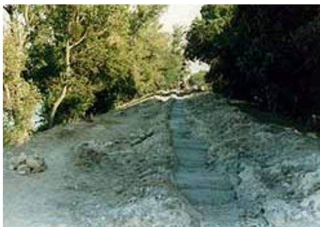
Figura 2.4 –Barreira de cimento-bentonita sem cobertura (Fonte: www.mdhsolutions.com/services/agrium.html )
