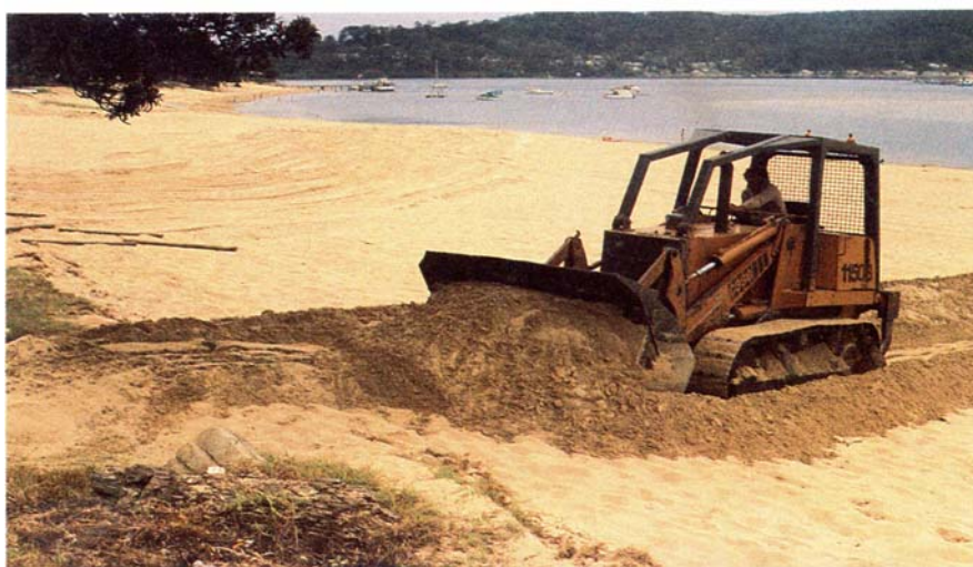
Figura 34. Estabilização das dunas construídas através de máquinas (extraído de Tabajara, 2000).
