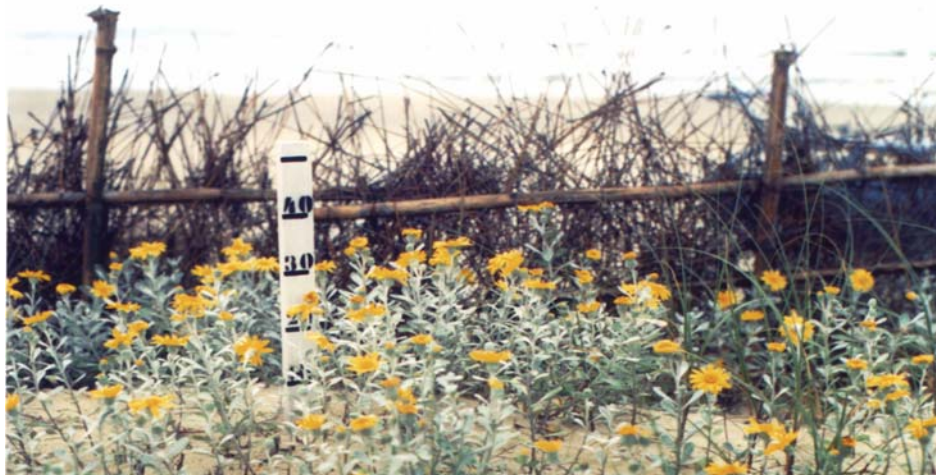
Figura 36. Esteiras de palha no sentido transversal ao vento predominante (Tabajara, 2000).
