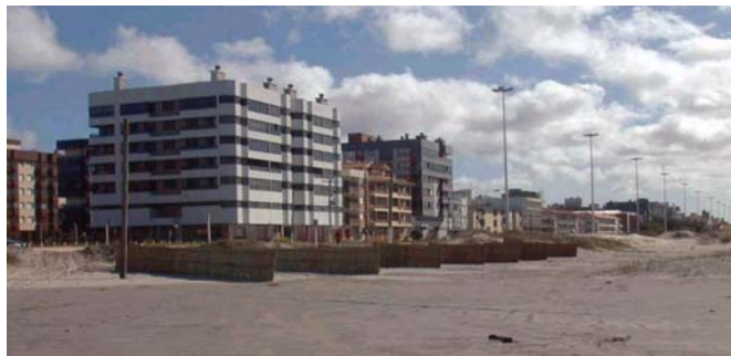
Figura 39. Esteiras de palha no sentido transversal ao vento predominante (NE).
