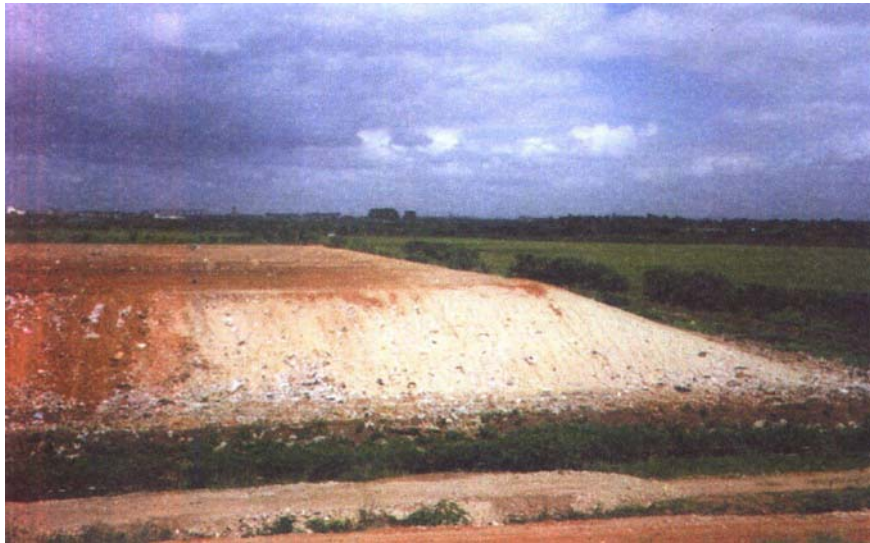
Figura 54. Célula de aterro sanitário tronco-piramidada executada em área (Bidone, 1999).
