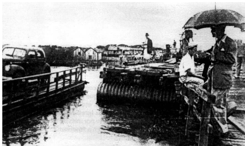
Figura 3. A travessia da Barra do João Pedro, por muitos anos, foi realizada por balsa. A partir da década de 40, foi construída uma ponte flutuante suportada por tonéis. Em 1956, o DAER construiu no local a ponte de cimento armado, em pleno funcionamento até os dias de hoje (extraído de Verlindo, 1999).
