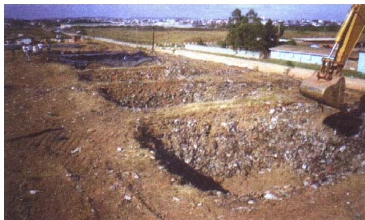
Figura 53. Escavação de trincheira de pequeno porte com utilização de retroescavadeira (Bidone, 1999).
