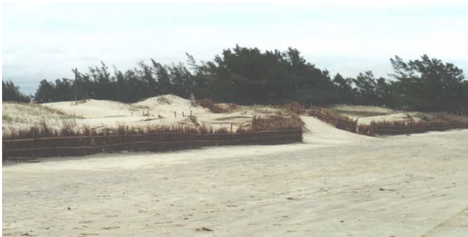
Figura 35. Instalação de esteiras paralelas ao mar, com aberturas a cada 30 metros ou mais de distância, a fim de permitir a passagem dos banhistas (Tabajara, 2000).
