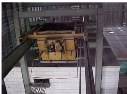
Figura 18: Transporte automatizado do concreto fresco do misturador para o funil de alimentação do equipamento de vibro-compressão Fonte: Obtido junto a empresa
