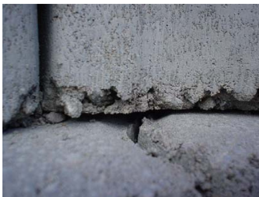
Figura 62: Escape de concreto pela parte inferior do molde (realçado) Fonte: Obtido junto a empresa
