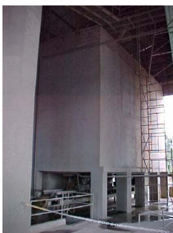
Figura 13: Estoque de agregados – silos fechados e cobertos com sensor de volume Fonte: Obtido junto a empresa
