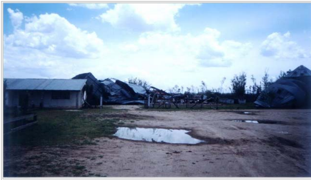
Figura 2.13- Silos destruídos pela tormenta - cidade de Viamão-RS
