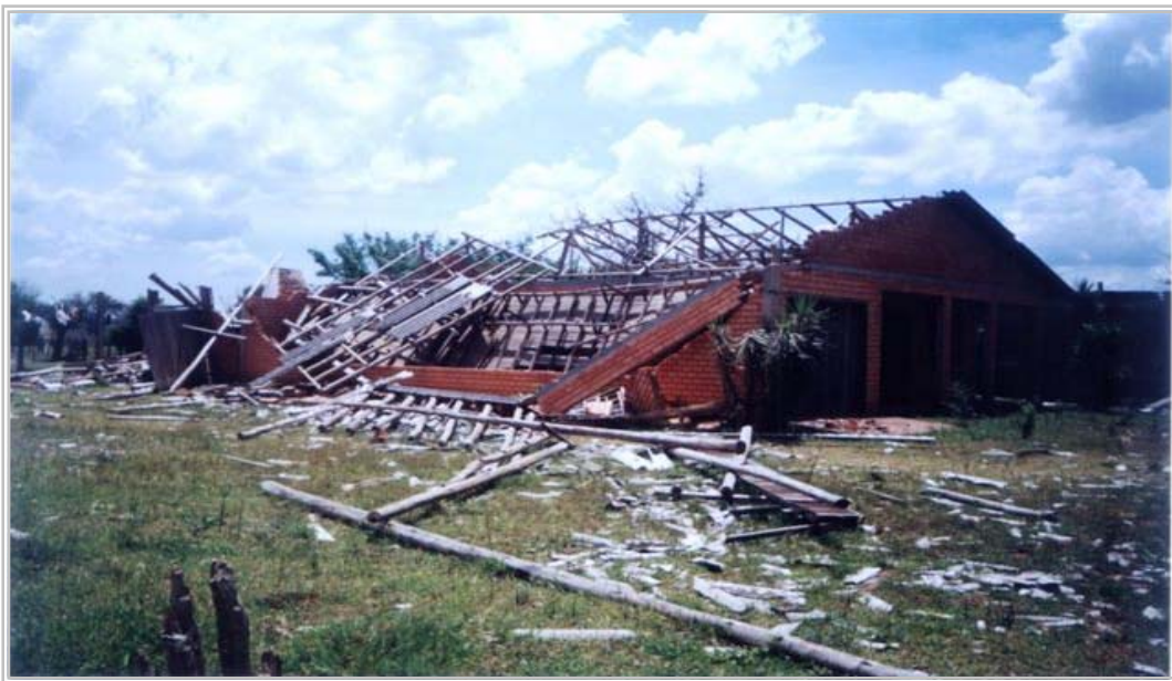
Figura 2.12 – Casa destruída pela tempestade- cidade de Viamão-RS
