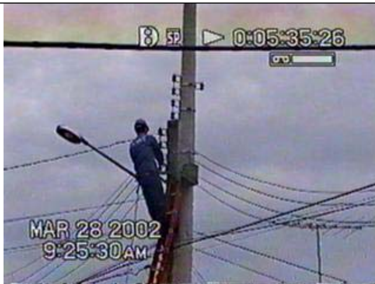
Figura 56: Uso de escada para escalar e descer do poste.
