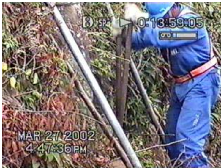
Figura 57: Abertura manual de cava utilizando trado.
