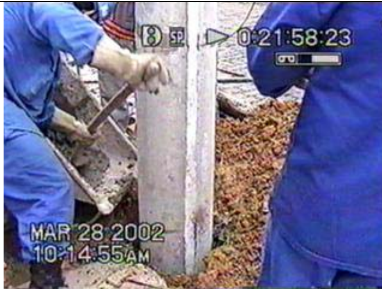
Figura 58: Fechamento manual de cava de poste de concreto.
