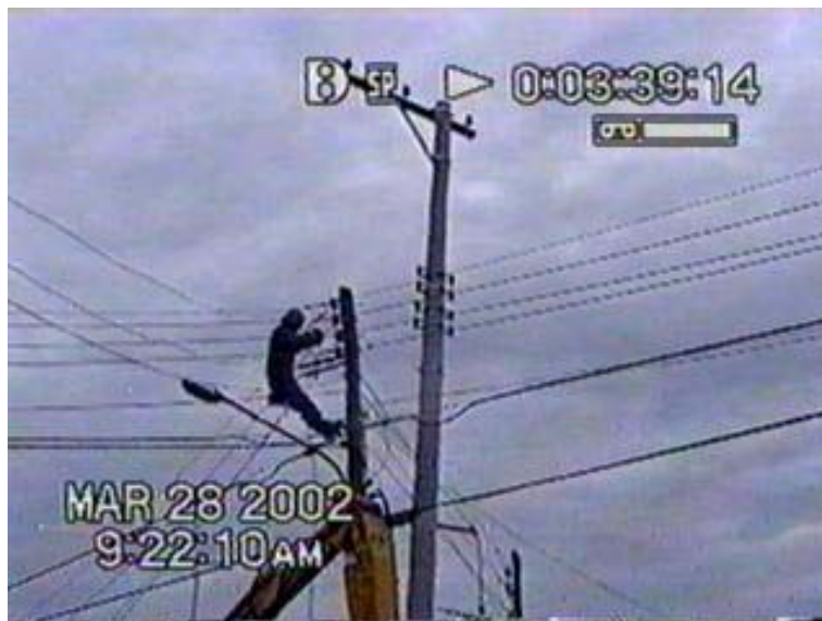
Figura 51: Alguns elementos do sistema elétrico de distribuição.
