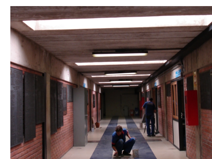
Figura 7: Vista interna do corredor da circulação do Prédio 30 Bloco B.
