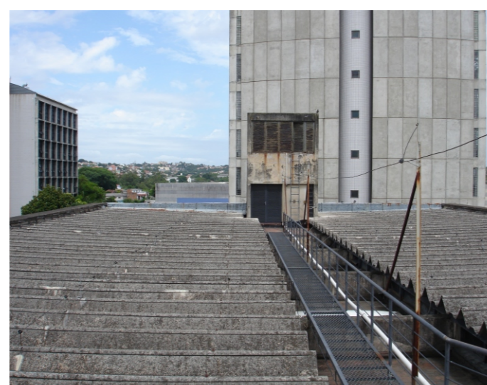
Figura 2: Vista externa da cobertura do Prédio 30 Bloco B.
