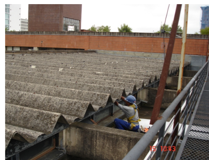
Figura 3: Colocação do aparelho para levantamento de temperatura.
