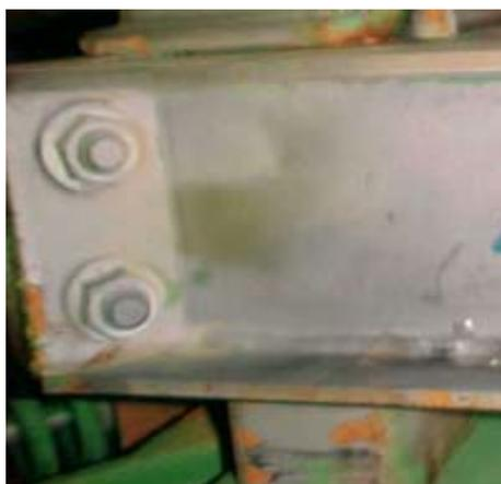
Figura 4.1 – Peça após a aplicação do jato de areia.
