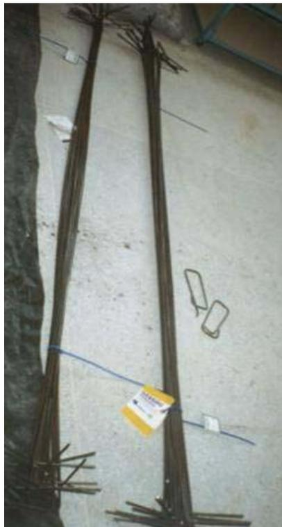
Figura 4.19 – Armaduras cortadas e dobradas pelo próprio fabricante.
