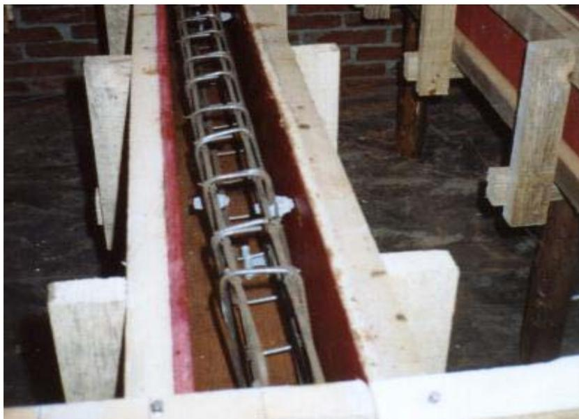
Figura 4.11 – Aspecto das armaduras posicionadas nas formas para concretagem
