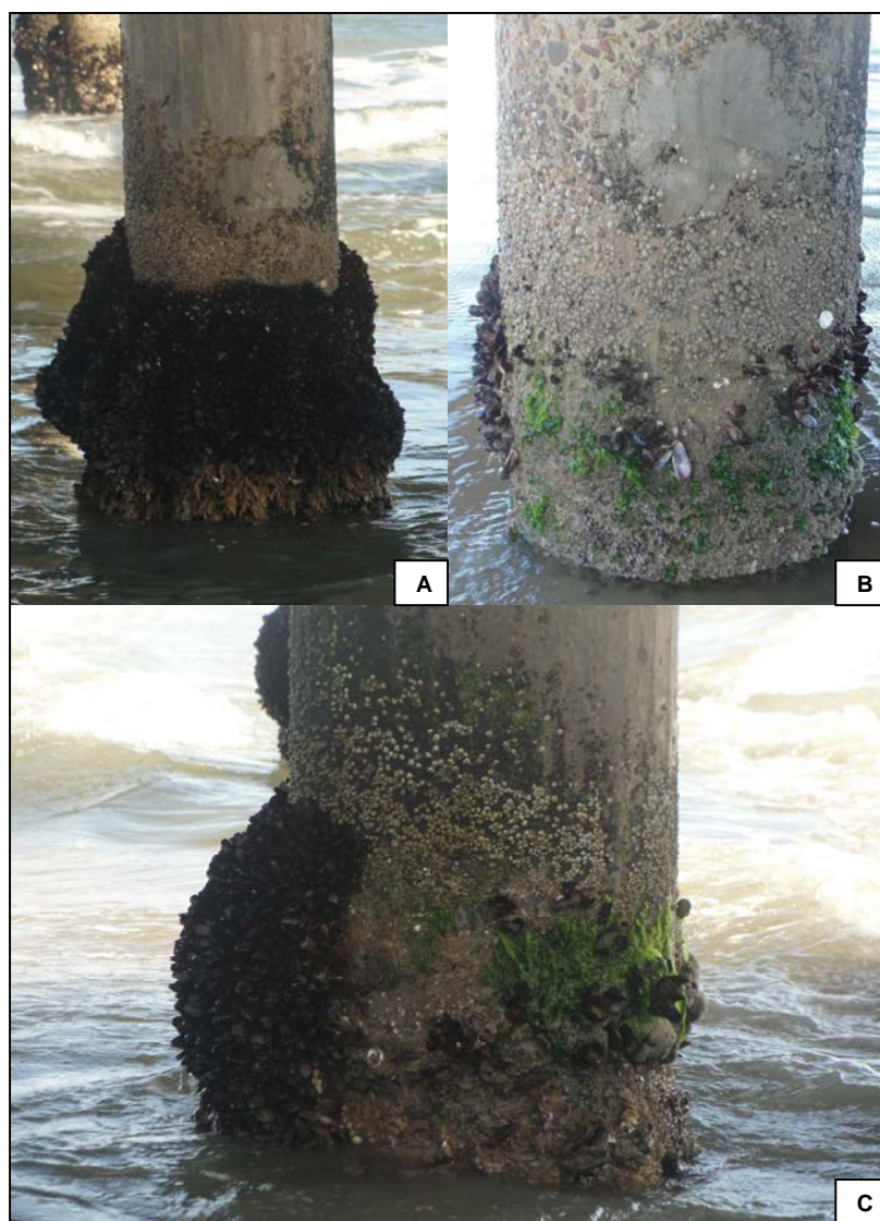
Figura 16 – Distribuição dos organismos nos pilares das plataformas de pesca do litoral norte do RS. A: colonização do pilar da plataforma de Tramandaí, com ênfase na população de Perna perna . B: representação da ocupação de um nicho inferior por Chtamalus bisinuatus , diminuição do diâmetro e da altura das zonas, perda de indivíduos ao longo do entorno do pilar e desaparecimento de Ectopleura sp. (pilar intermediário). C: presença das macroalgas Enteromorpha sp. e Ulva lactuca no pilar da plataforma de pesca, ocupando o litoral protegido. Fonte: autora (2011).
