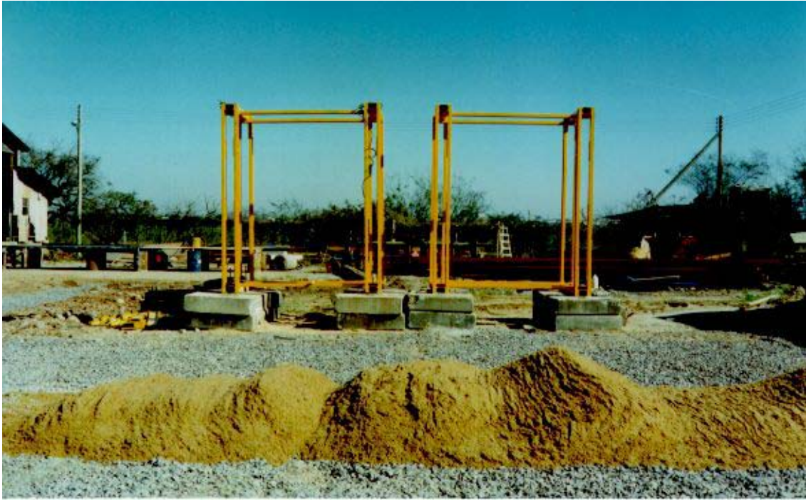
Figura 3.6 – Estruturas de carregamento montadas sobre oito contrapesos de grua cada, antes da compactação da primeira camada do aterro.
