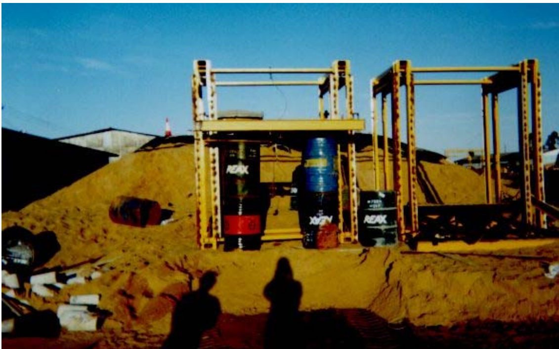
Figura 3.7 – Estruturas de carregamento e estrados. O estrado de pesos correspondente ao geotêxtil superior está apoiado sobre tonéis, pronto para ser preso pelos cabos de aço.
