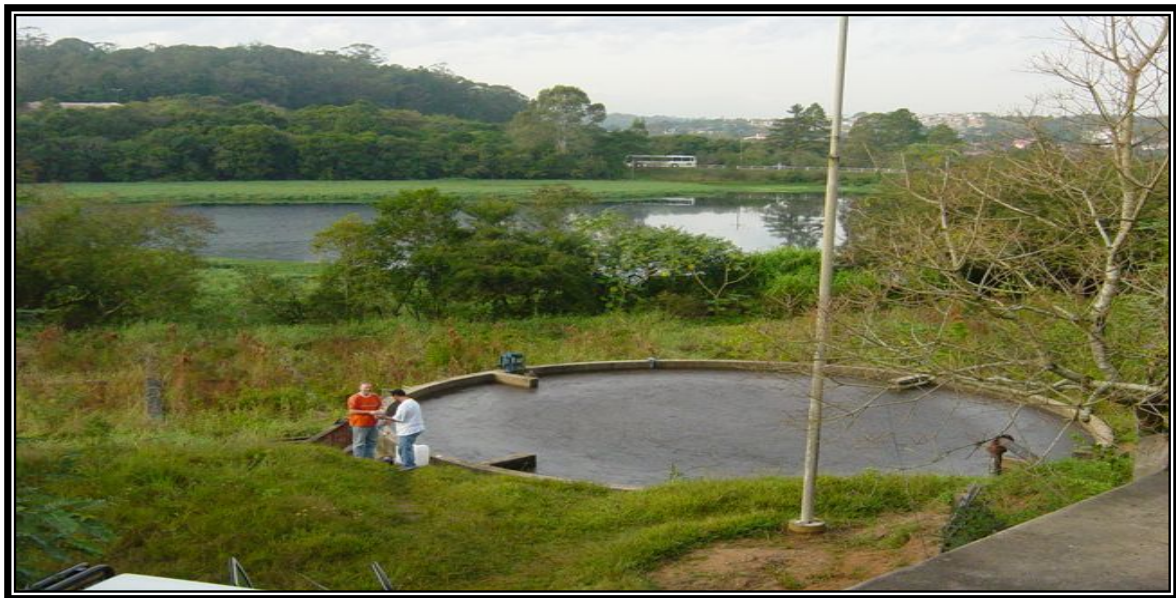
FIGURA 3: Estação de Tratamento de Esgoto Campus do Vale/UFRGS – Sistema de Reator Sequencial em Batelada
