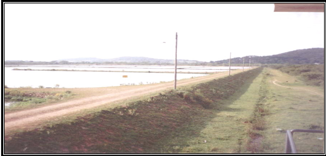
FIGURA 4: Estação de Tratamento de Esgoto Ipanema – Sistema de Lagoa Facultativa
