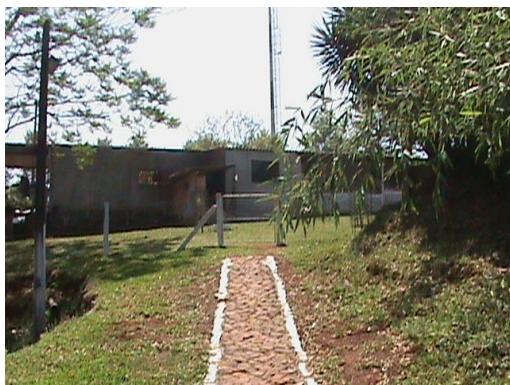
Figura 15: Vista do prédio de atendimento ao público e do COPOM (setor de telefonia)
