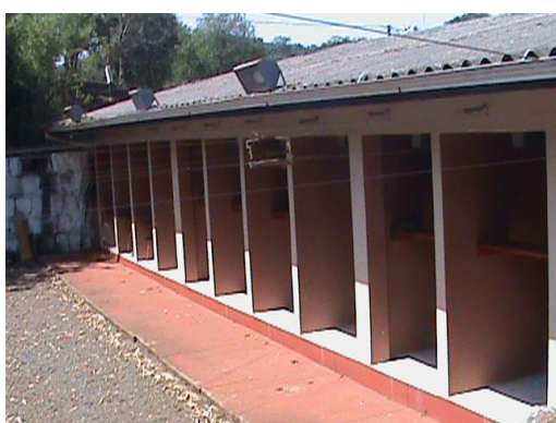
Figura 19: Estande de tiros – parte interna
