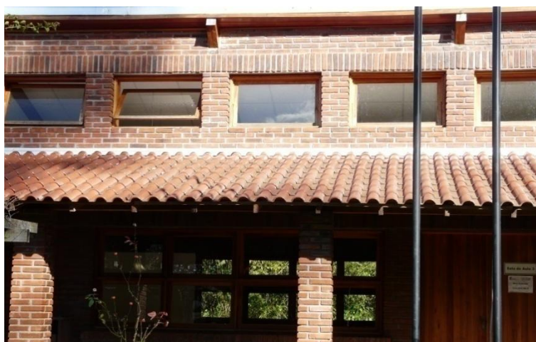
Figura 10 – Janelas superiores da fachada norte
