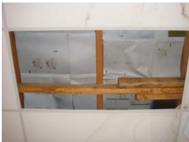
Figura 13 – Chapas de alumínio entre o forro e o telhado
