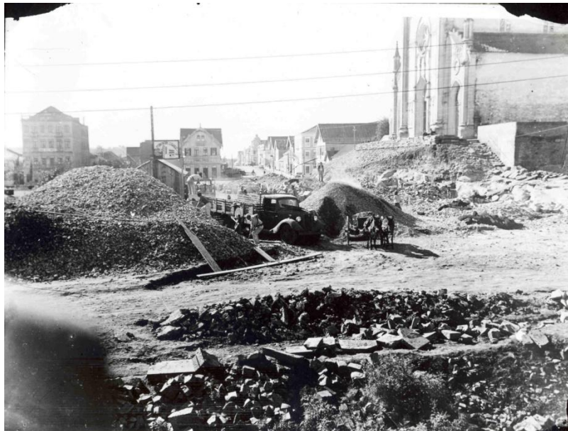
Fotografia 10 – Obras de rebaixamento da porção sul da praça Dante Alighieri, na década de 30 (séc. XX)
