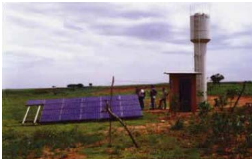
Figura 2.4: Sistema de bombeamento fotovoltaico – Santa Cruz I (Mirante do Paranapanema – SP) FONTE: UNIVERSIDADE DE SÃO PAULO, 2000.
