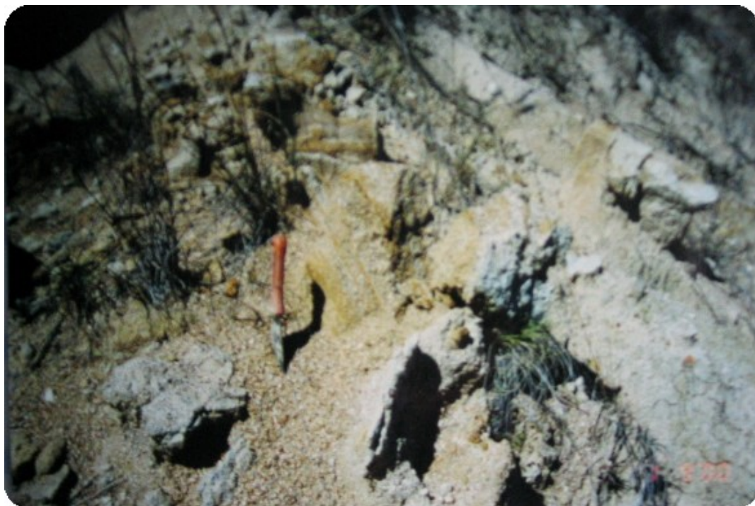
Figura A.9 – Areia grossa resultante da erosão no km 112 + 050.
