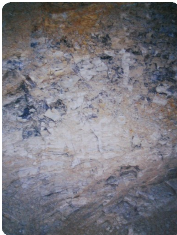
Figura 2.16: Fotos LE no km 112 + 400 junto à erosão (ampliada)
