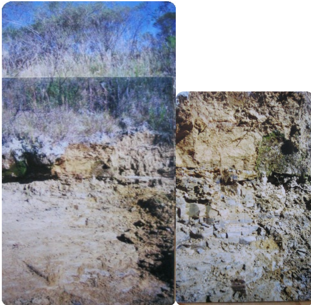
Figura 2.17: Foto talude LD e ampliada, na face do talude (km 112 + 400)
