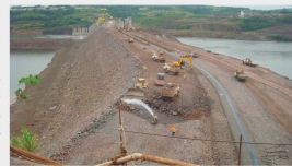
Foz do Chapecó tem primeira barragem com núcleo de asfalto no Brasil
