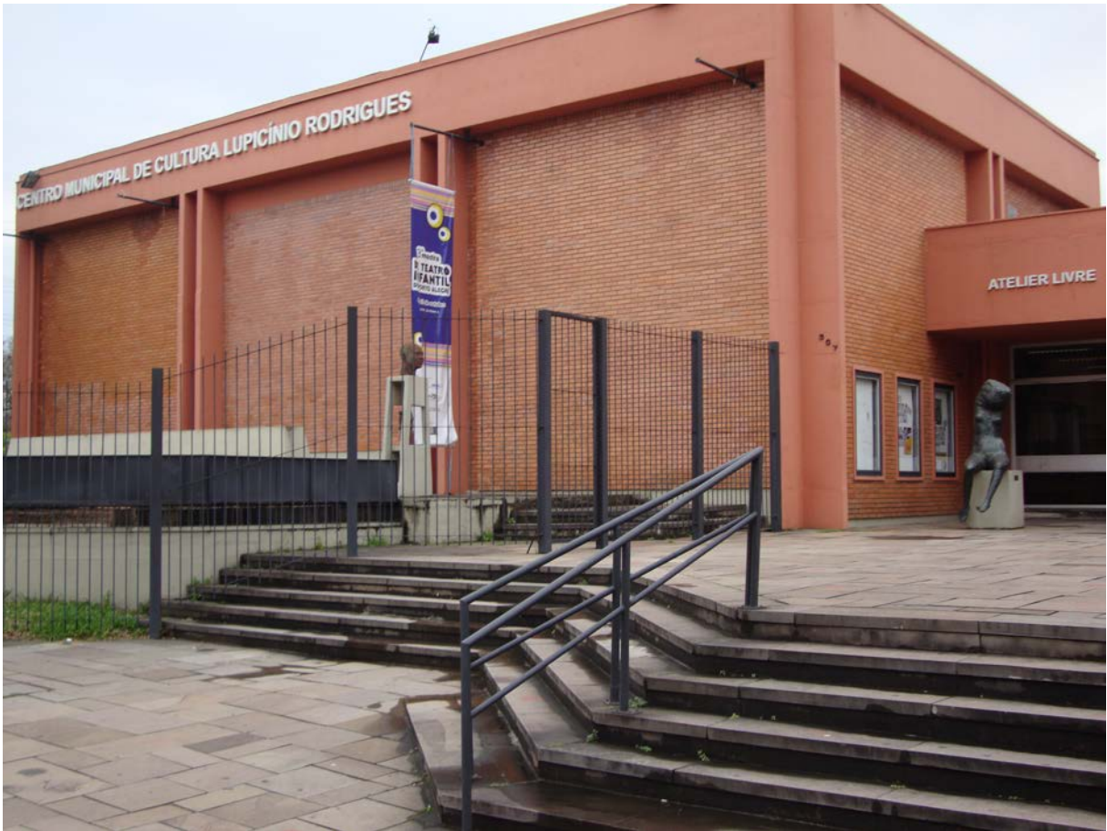
Fig. 11. Detalhes da fachada do CMC. Foto de Felipe Oliveira dos Anjos.
