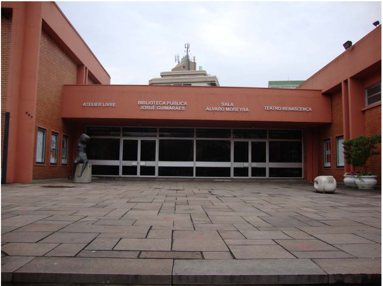
Fig. 12. Detalhe da vista frontal do CMC. Foto de Felipe Oliveira dos Anjos
