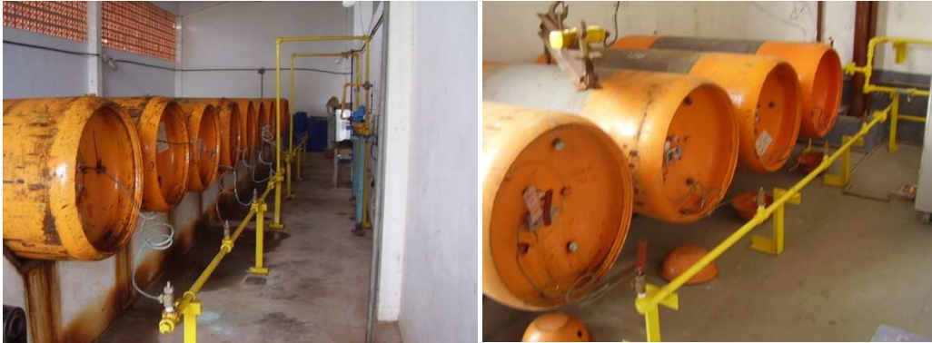
Figura 11. Fotos de baterias de cilindros comparando sistemas sem e com evaporador de cloro.
