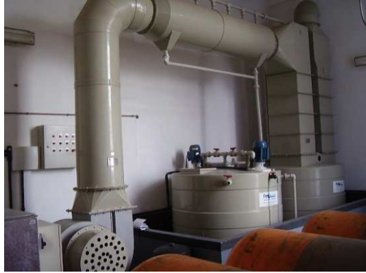
Figura 15. Lavador de Gases instalado na ETA Cachoeirinha.
