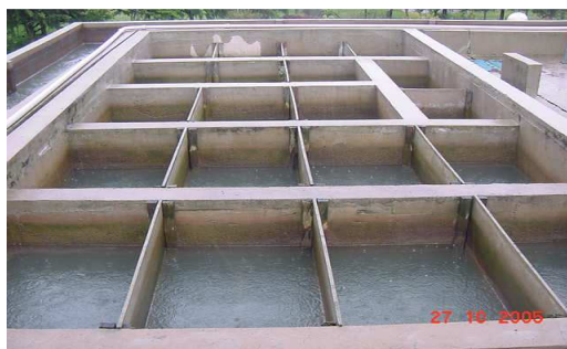
Figura 2. Foto de floculador em ETA.
