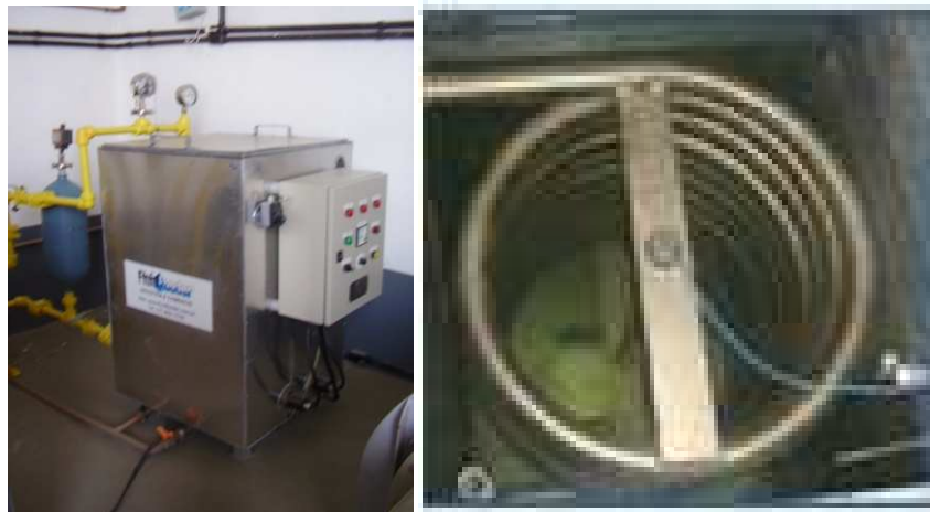
Figura 7. Fotos do Evaporador de Cloro Fluid Feeder Série 200 e da serpentina.
