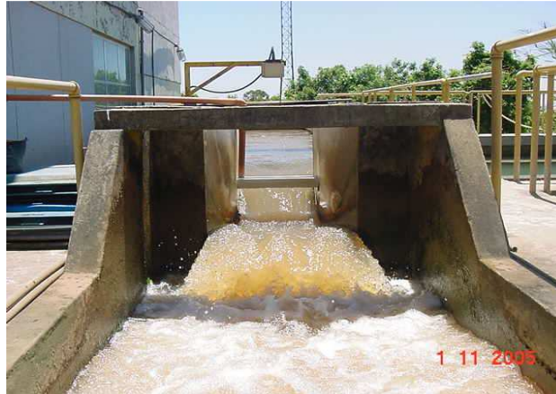
Figura 1. Aplicação de coagulante no ressalto hidráulico.
