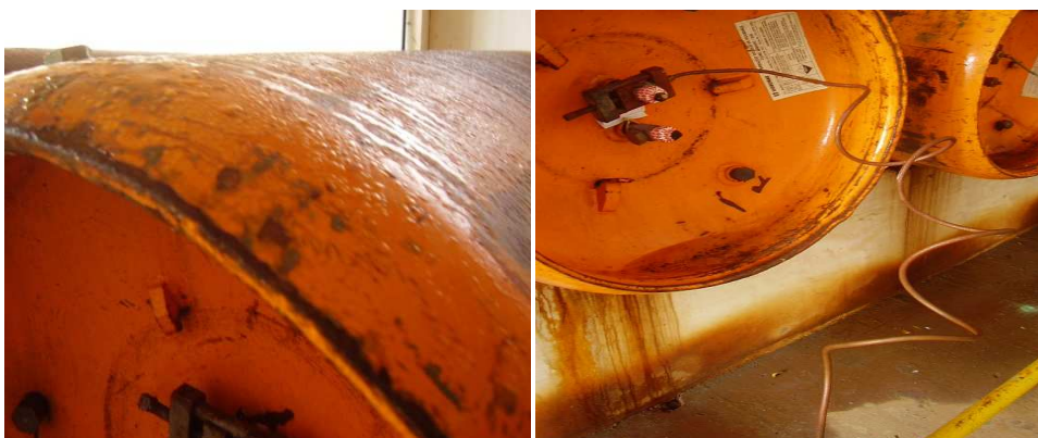
Figura 12. Fotos de cilindros com umidade condensada na superfície.
