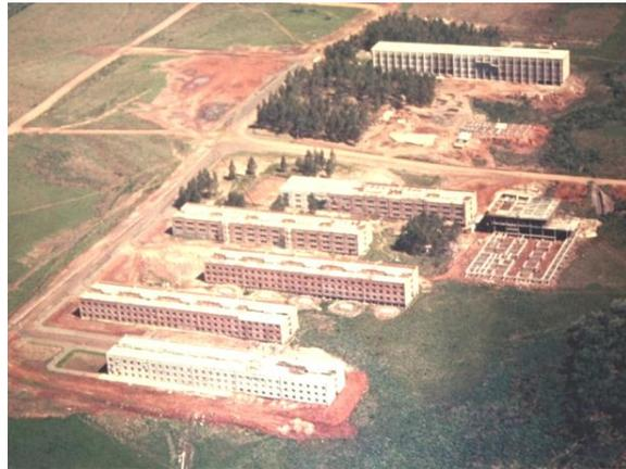
**Figura 108:** Foto da construção dos blocos residenciais para estudantes, já em finalização, e da União Universitária, com parte já edificada e restante ainda nas fundações (FONTE: Acervo da UFSM, 2009).
