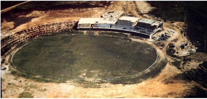
**Figura 116:** Início da construção do Estádio, com a edificação dos quatro blocos de arquibancada, e as fundações de outros blocos que acabaram nunca sendo edificados (FONTE: Acervo da UFSM, 2009)
