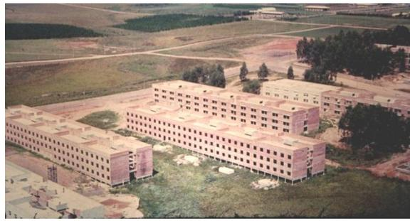
**Figura 107:** Foto aérea da construção dos blocos residenciais para estudantes, edificados em três pavimentos diretamente apoiados sobre o solo (FONTE: Acervo da UFSM, 2009).
