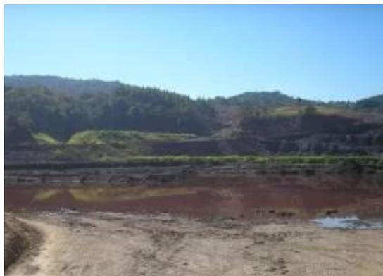
Figura 2. Drenagem Ácida de Minas gerada a partir da oxidação de sulfetos em bacias de rejeito de carvão dispostas a céu aberto.
