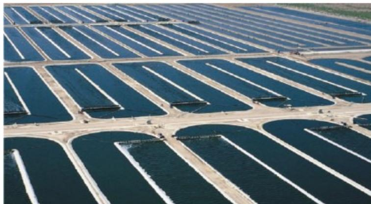
**Figura 3 - Cultivo de microalgas em lagoas "raceway"**
