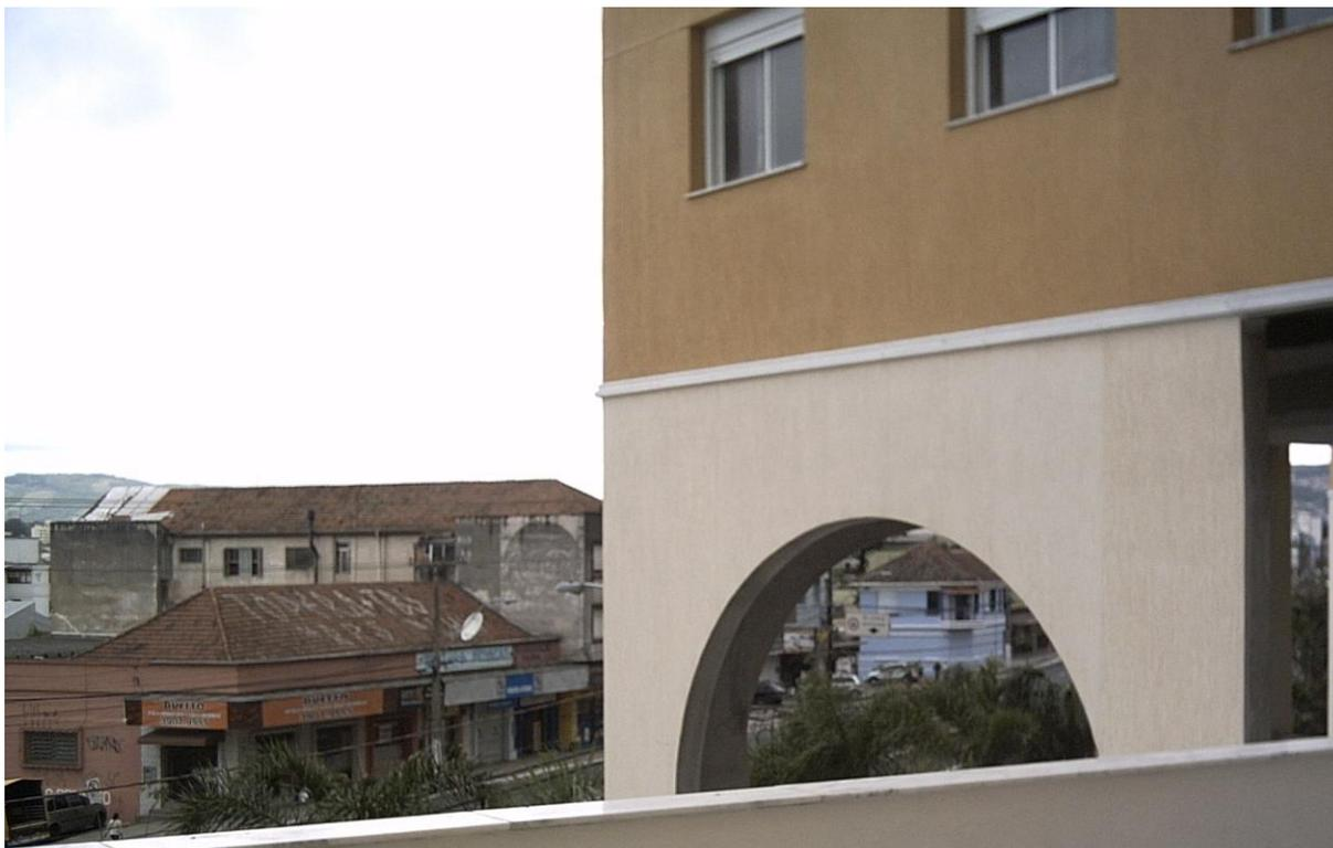
Figura 10: moldura posicionada na transição de cores, funcionando como pingadeira
