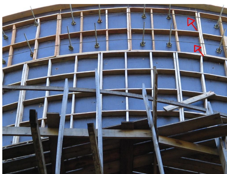
Figura 22: fôrmas externas da parede do reservatório
