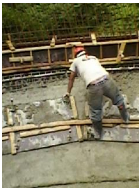
Figura 30: nivelamento da superfície do fundo inclinado
