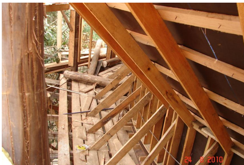
Figura 16: escoramento do fundo inclinado
