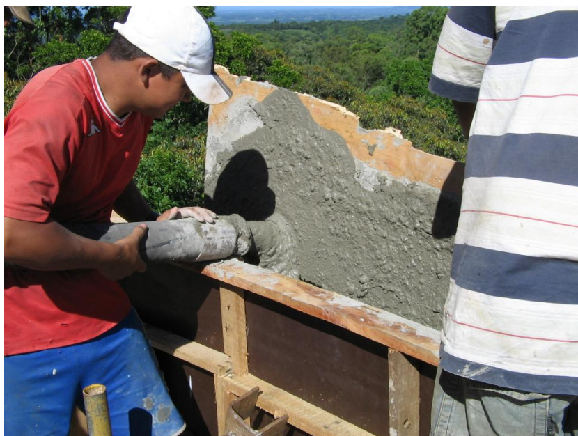
Figura 32: lançamento do concreto na parede do reservatório
