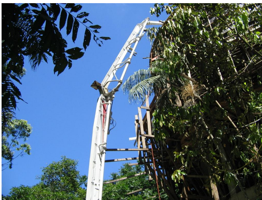
Figura 31: lança do caminhão-bomba usada na concretagem da parede do reservatório
