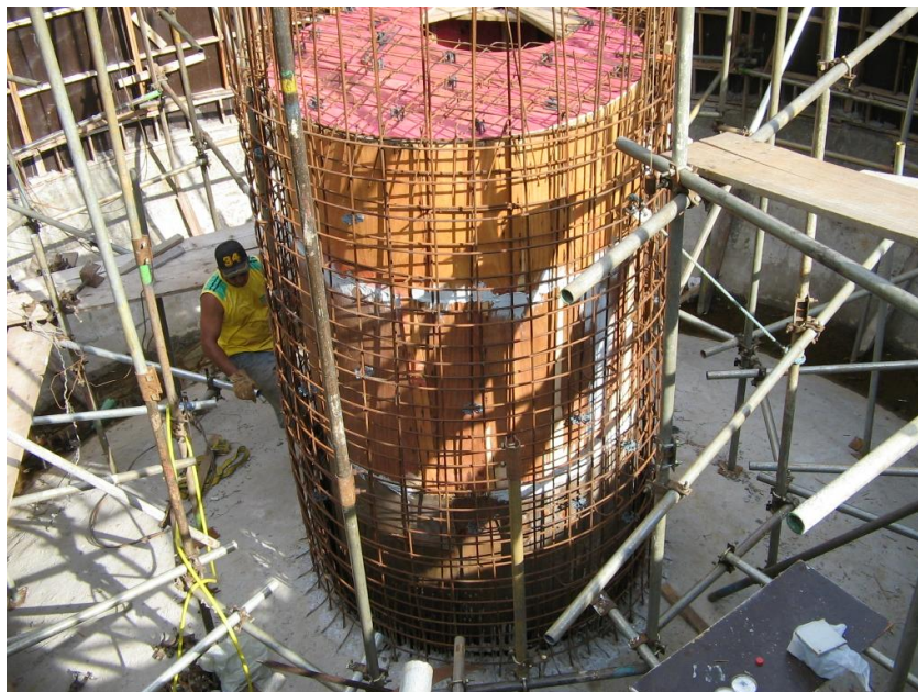
Figura 23: escoramento da parede do reservatório e cilindro interno
