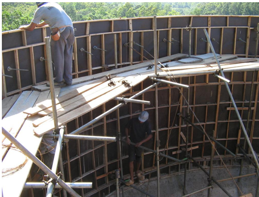
Figura 25: escoras e fôrmas internas da parede do reservatório
