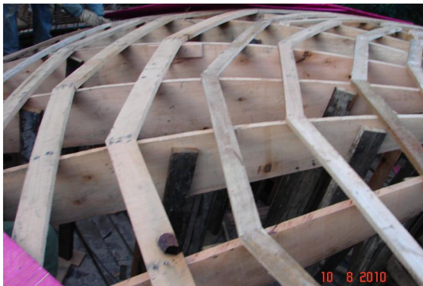
Figura 13: escoramento e detalhe construtivo do fundo esférico
