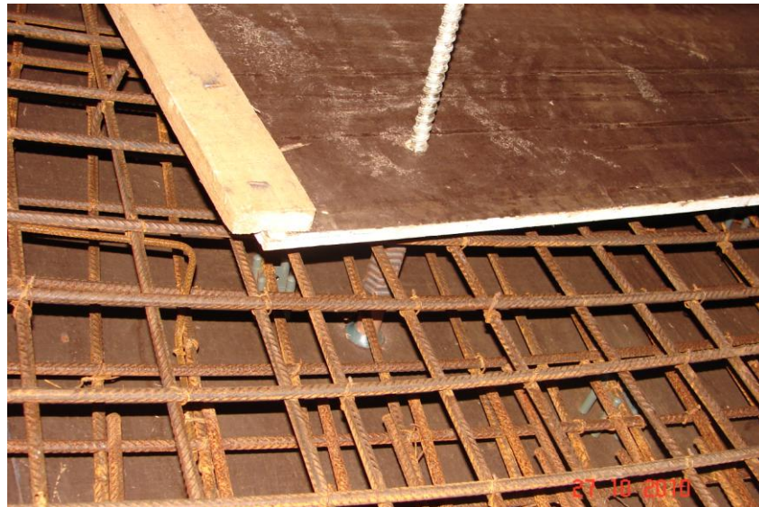
Figura 19: sistema de travamento das fôrmas do fundo inclinado
