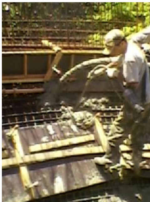
Figura 29: lançamento e vibração do concreto no fundo inclinado
