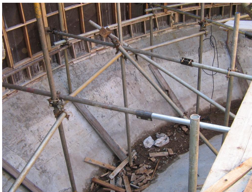
Figura 24: escoras da parede do reservatório
