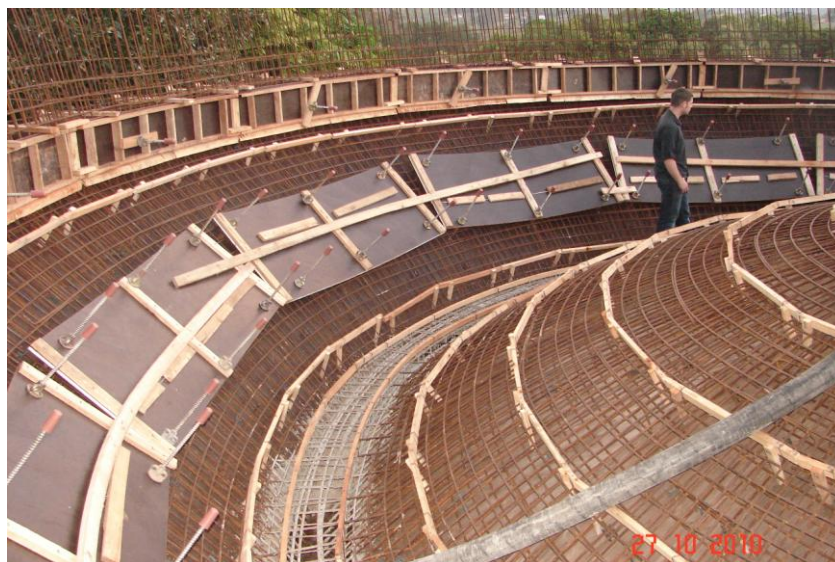
Figura 27: sistema para nivelamento da superfície do fundo esférico e inclinado
