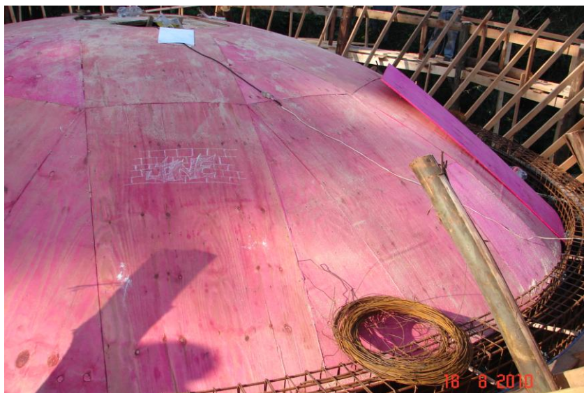
Figura 15: escoramento do fundo inclinado e fôrma do fundo esférico
