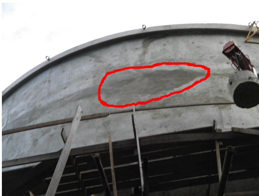
Figura 37: parede do reservatório com o reparo de argamassa estrutural
