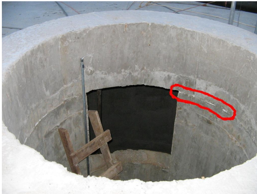
Figura 34: abertura do cilindro interno e isopor usado na junta de concretagem
