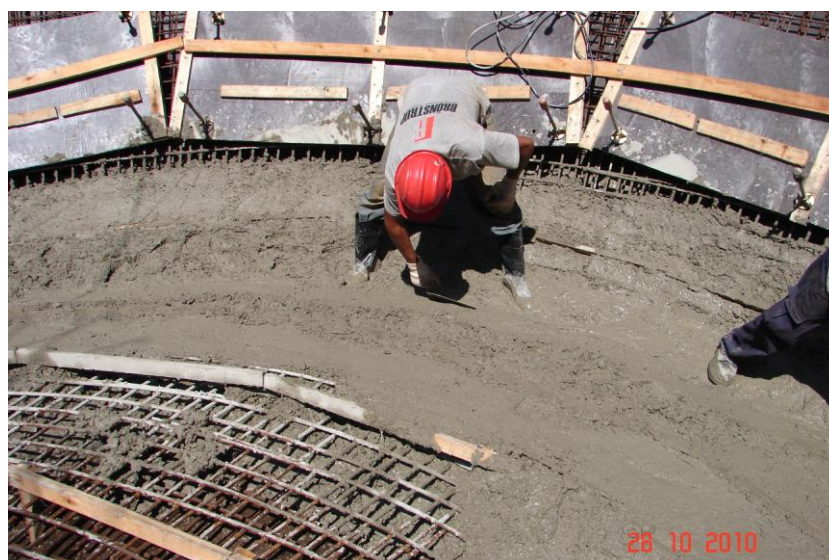
Figura 28: início da concretagem do fundo e complementação do topo da viga circular
