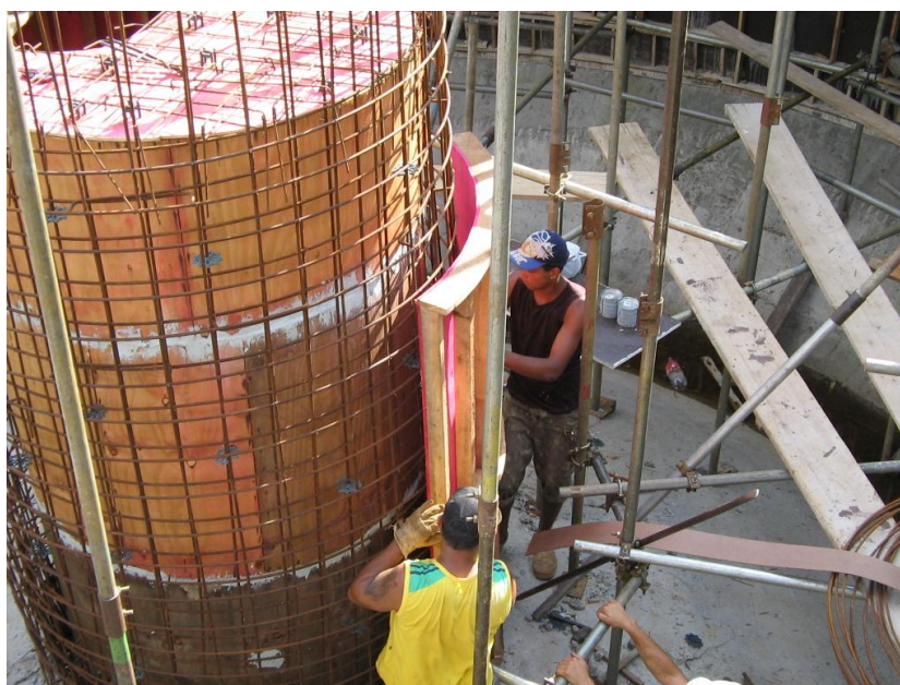
Figura 26: fôrma da parede do cilindro interno
