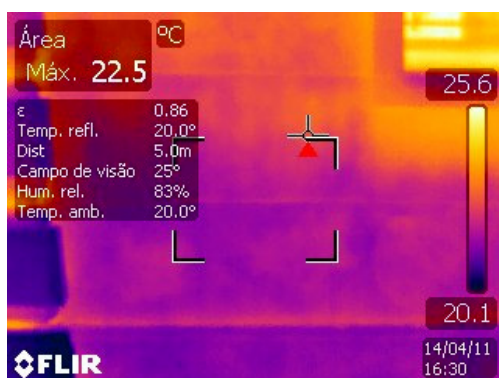
Figura 26: imagem termográfica do Observatório Astronômico da UFRGS
