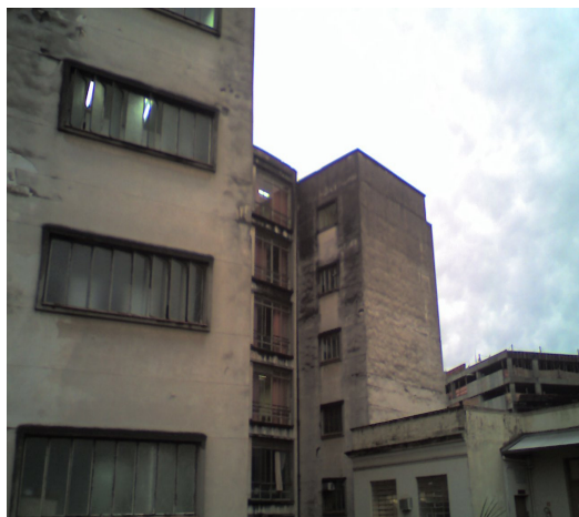
Figura 18: vista geral da fachada Leste
