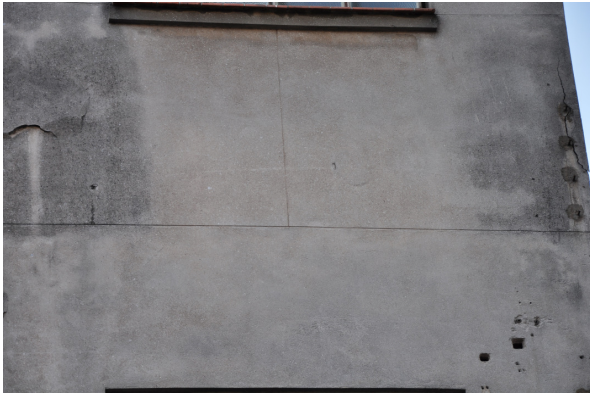
Figura 42: vista geral do revestimento
