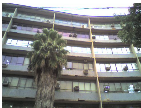
Figura 21: vista geral da fachada principal - orientação Norte
