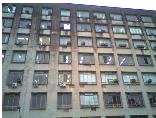
Figura 20: vista geral da fachada Sul
